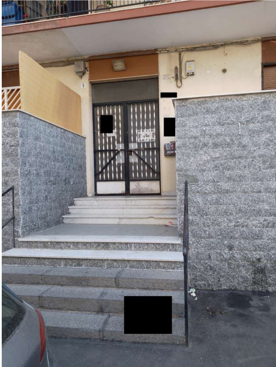
Foto 2 – Portone di Ingresso al Fabbricato
