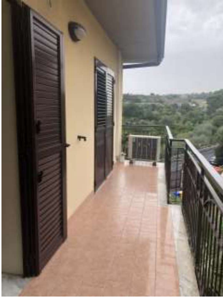
Foto 5 – Balcone lato nord
