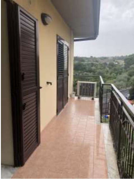
Foto 5 – Balcone lato nord
