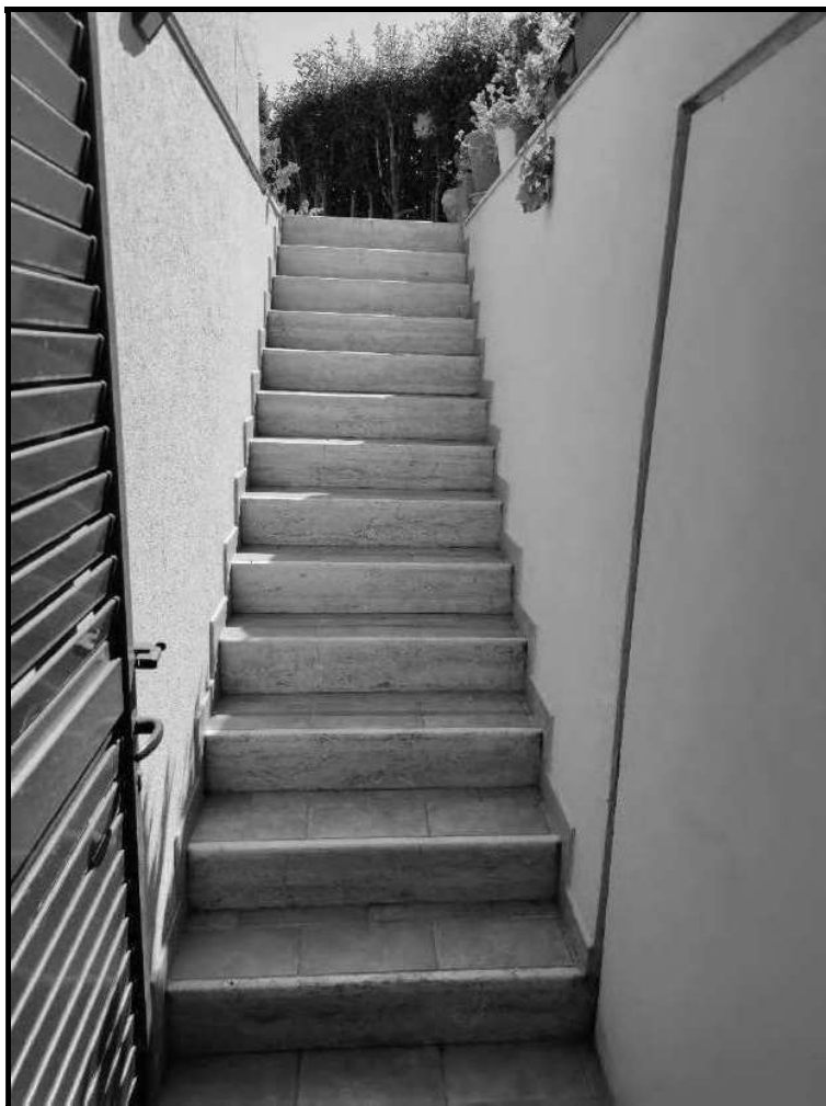
FOTO N. 56 (SCALA ESTERNA DI COLLEGAMENTO PIANO SEMINTERRATO E PIANO TERRA)
