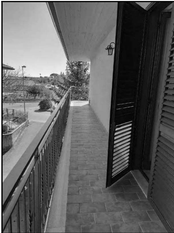
FOTO N. 49 (BALLATOIO A NORD)
