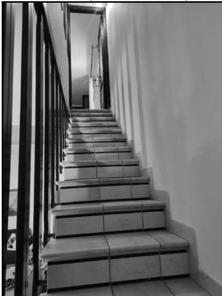
FOTO N. 50 (SCALA INTERNA DI ACCESSO AI LOCALI A PIANO INTERRATO)
