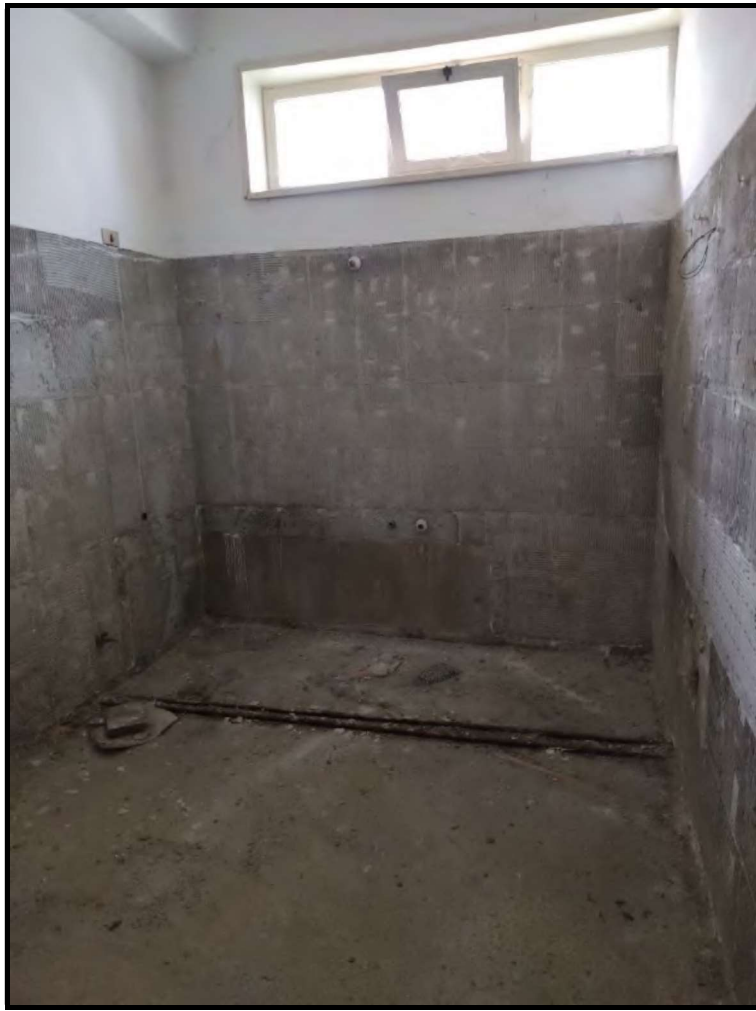
FOTO N. 23 (W.C. IN CORSO DI COSTRUZIONE)
