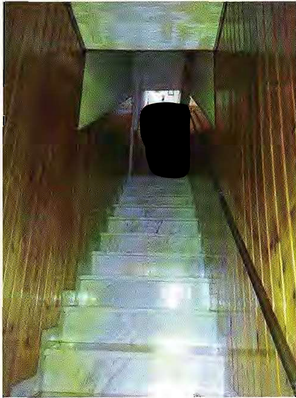
Foto n° 6 -Scala di collegamento ai piani
