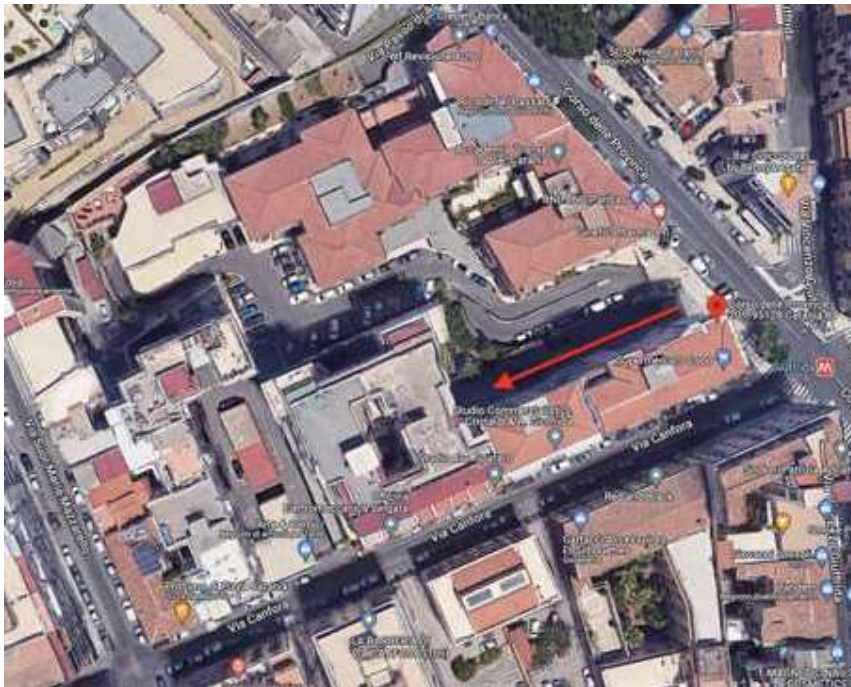
Indicazione rampa per l'accesso al garage al piano seminterrato
