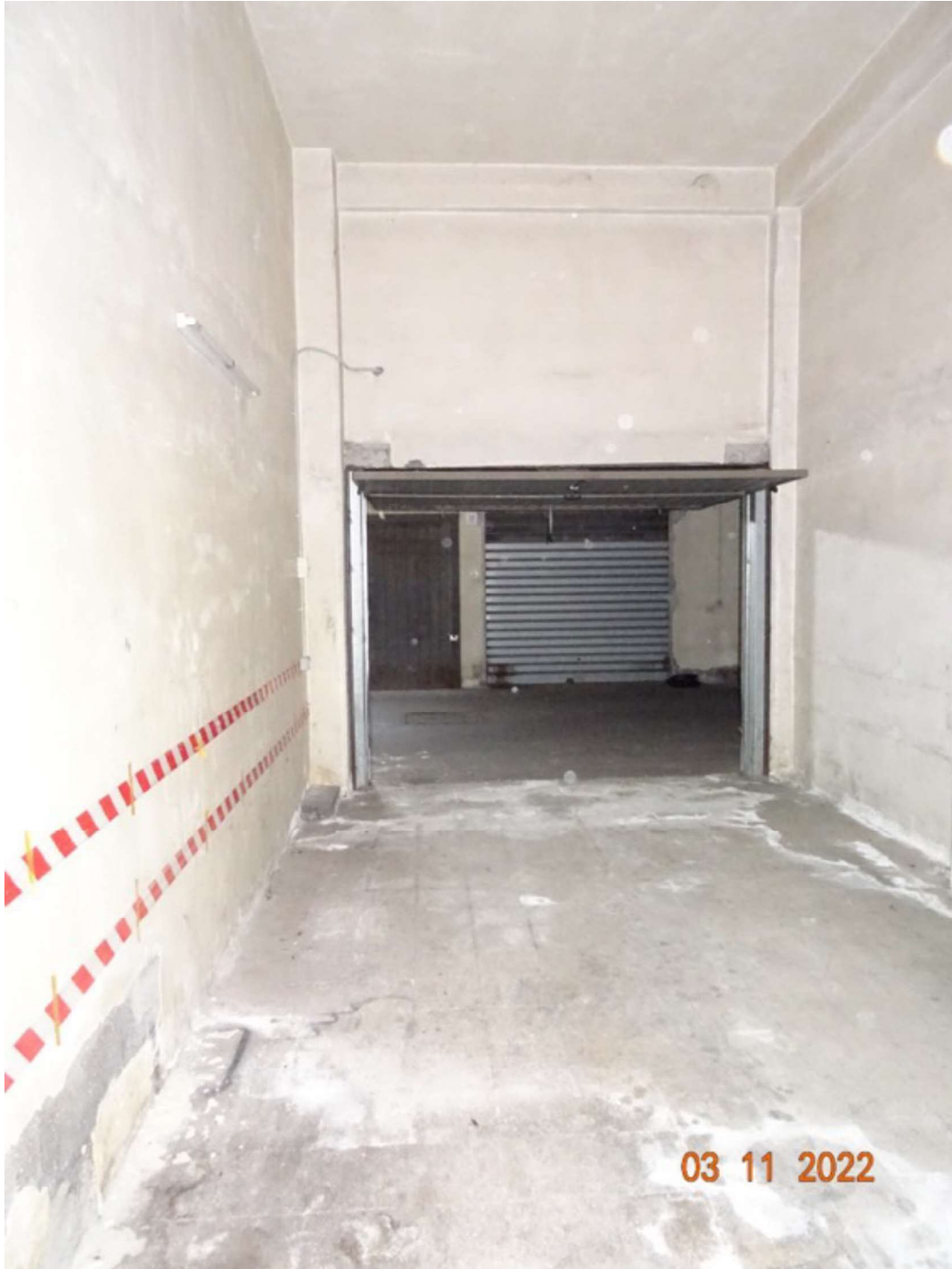
Vista dell'intero garage con ripresa spalle al fondo del garage
