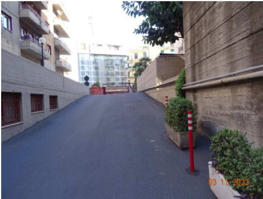
Rampa condominiale ripresa dalla parte finale verso l'ingresso
