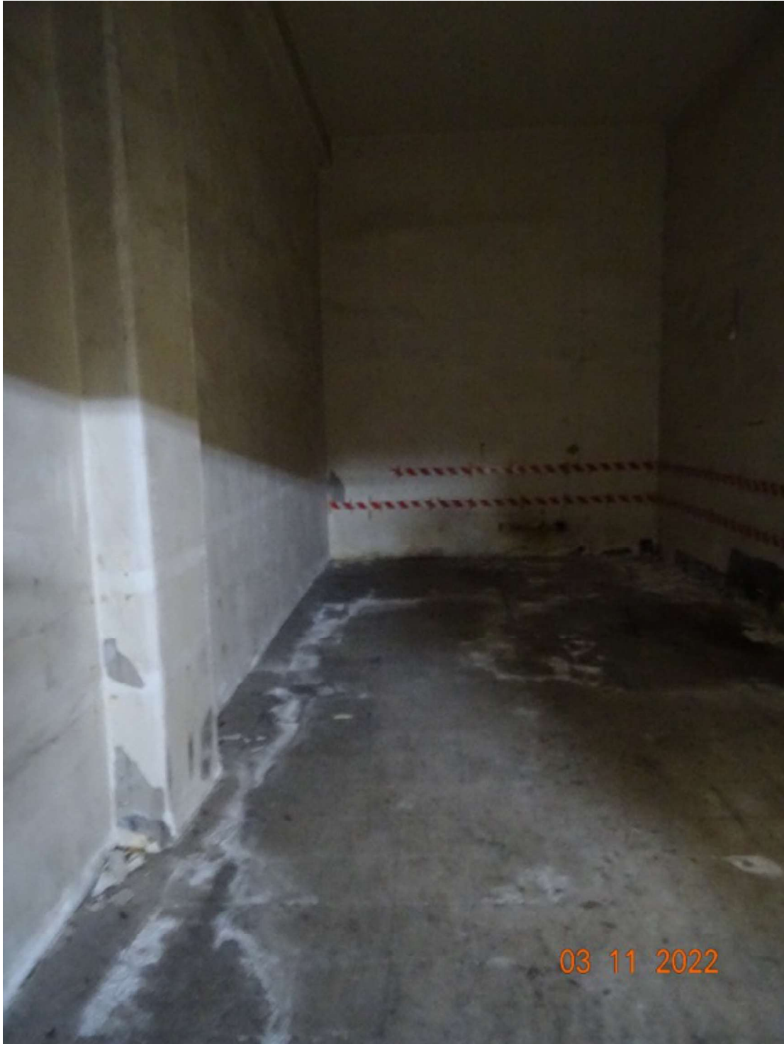
Interno del garage
