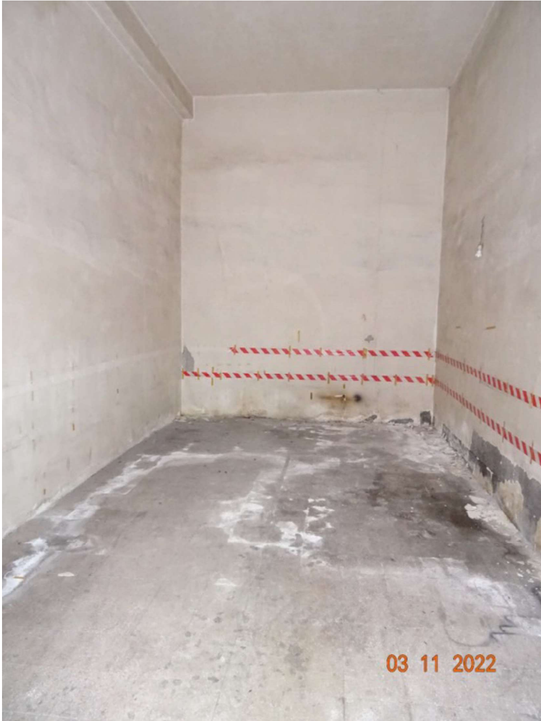
Vista intero garage con
