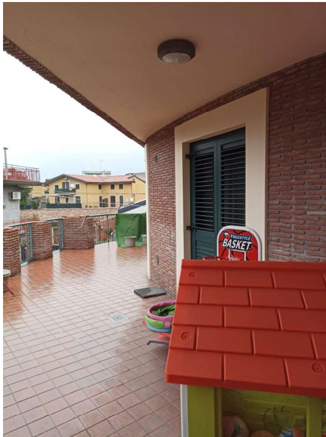
Foto 64 – Piano primo, vista del balcone
