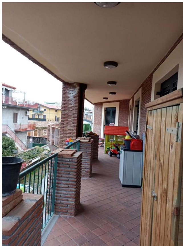
Foto 63 – Piano primo, vista del balcone
