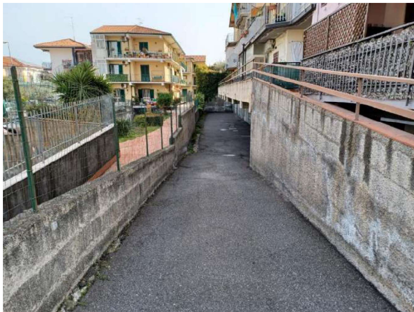
Foto 47 – Rampa che conduce alla zona garage
