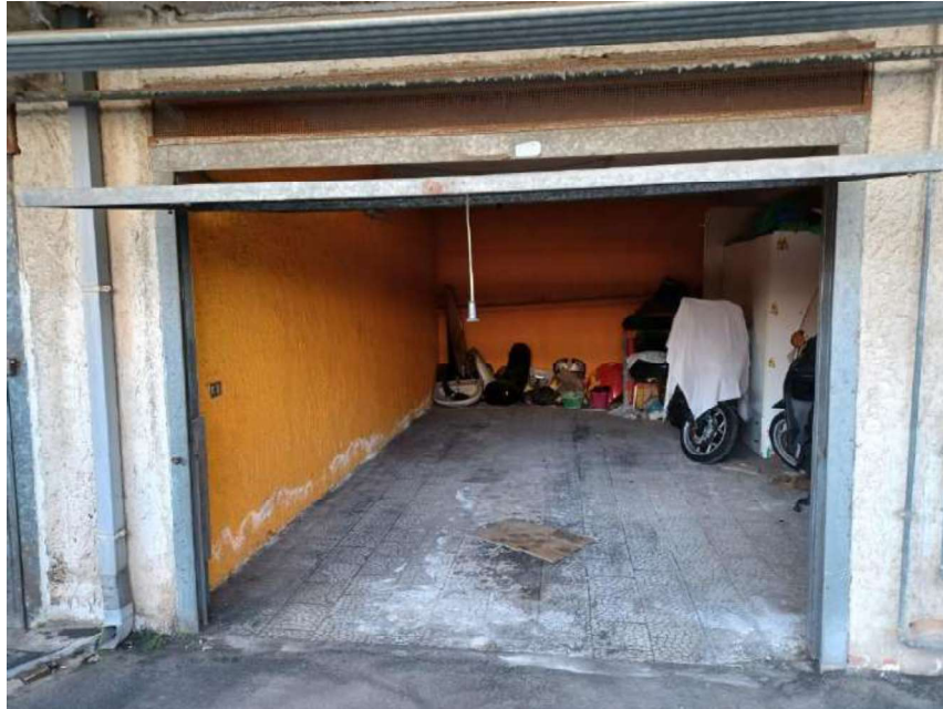
Foto 49 – Garage ( foglio 1 particella 388 sub 13 )
