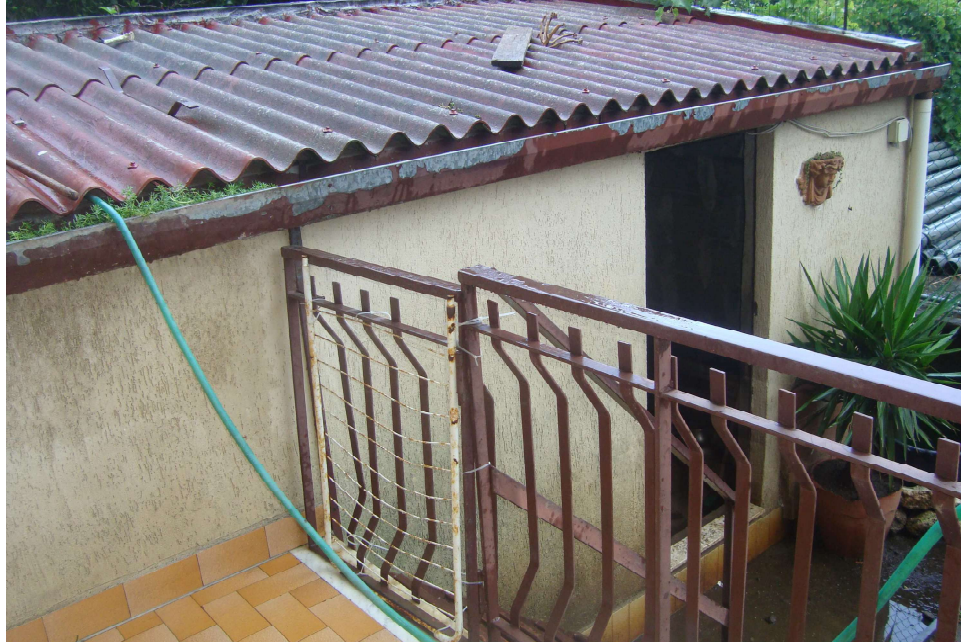
FOTO N. 32 Scala di accesso al terreno di pertinenza posto al lato Nord
