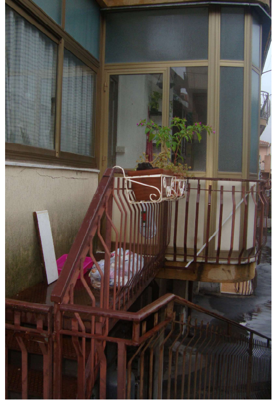
FOTO N. 4 Accesso alla Veranda lato Sud
