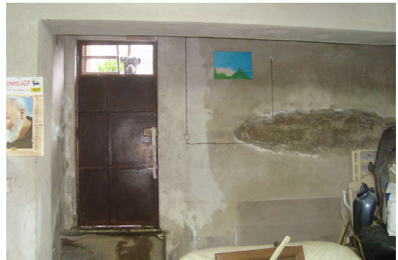
FOTO N. 31 Porta di accesso lato Nord
