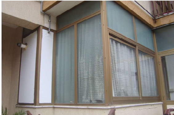
FOTO N. 5 Veranda lato Sud
