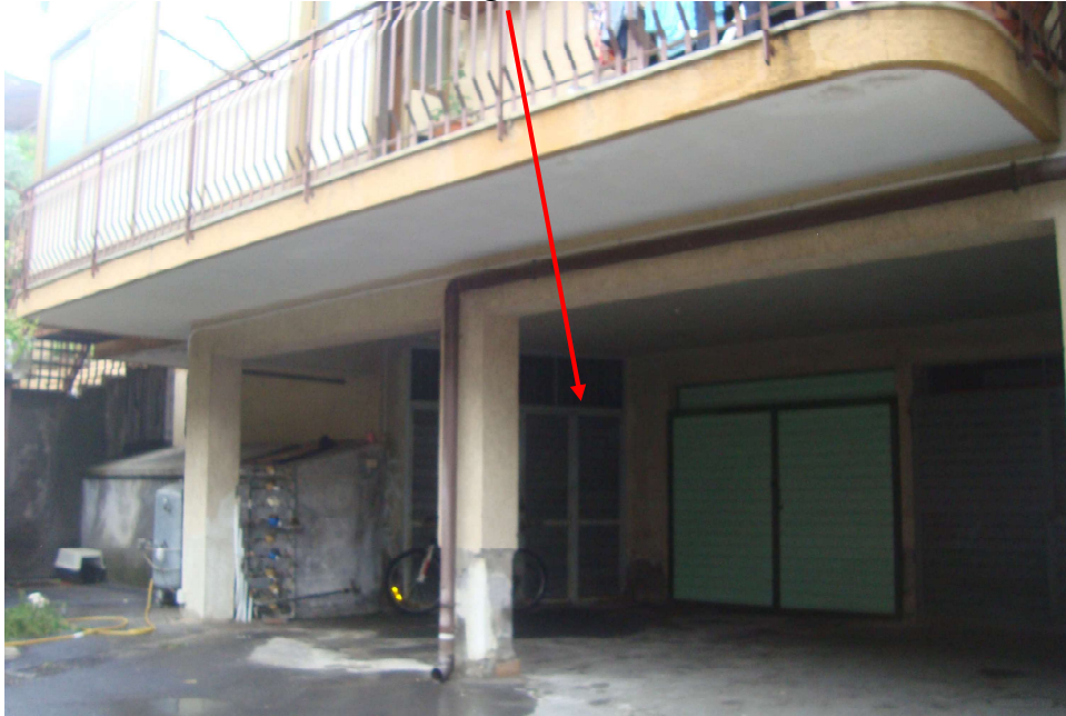
FOTO N. 24 Garage al Piano Terra lato Sud
