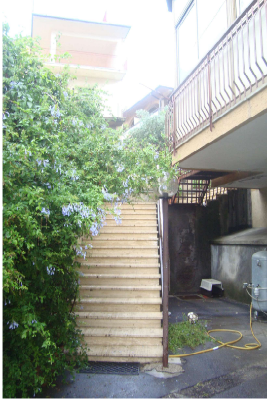
FOTO N. 3 Scala condominiale esterna
