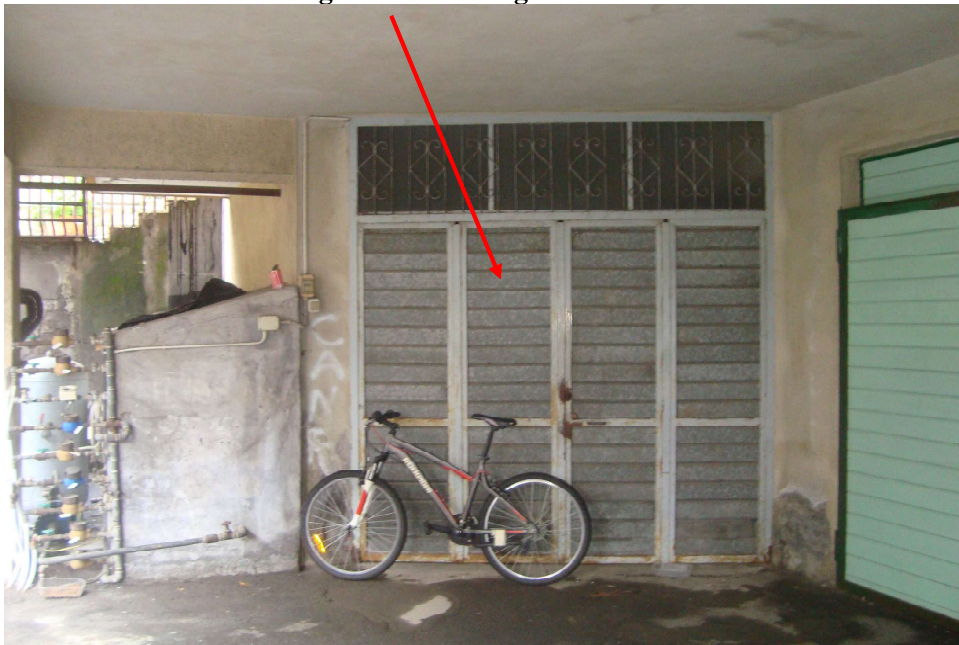
FOTO N. 25 Ingresso del Garage al Piano Terra lato Sud
