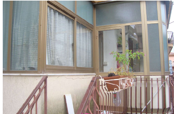
FOTO N. 6 Veranda lato Sud
