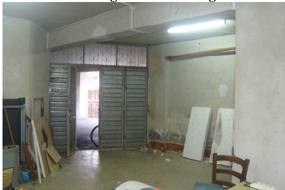
FOTO N. 30 Ingresso del Garage lato Est
