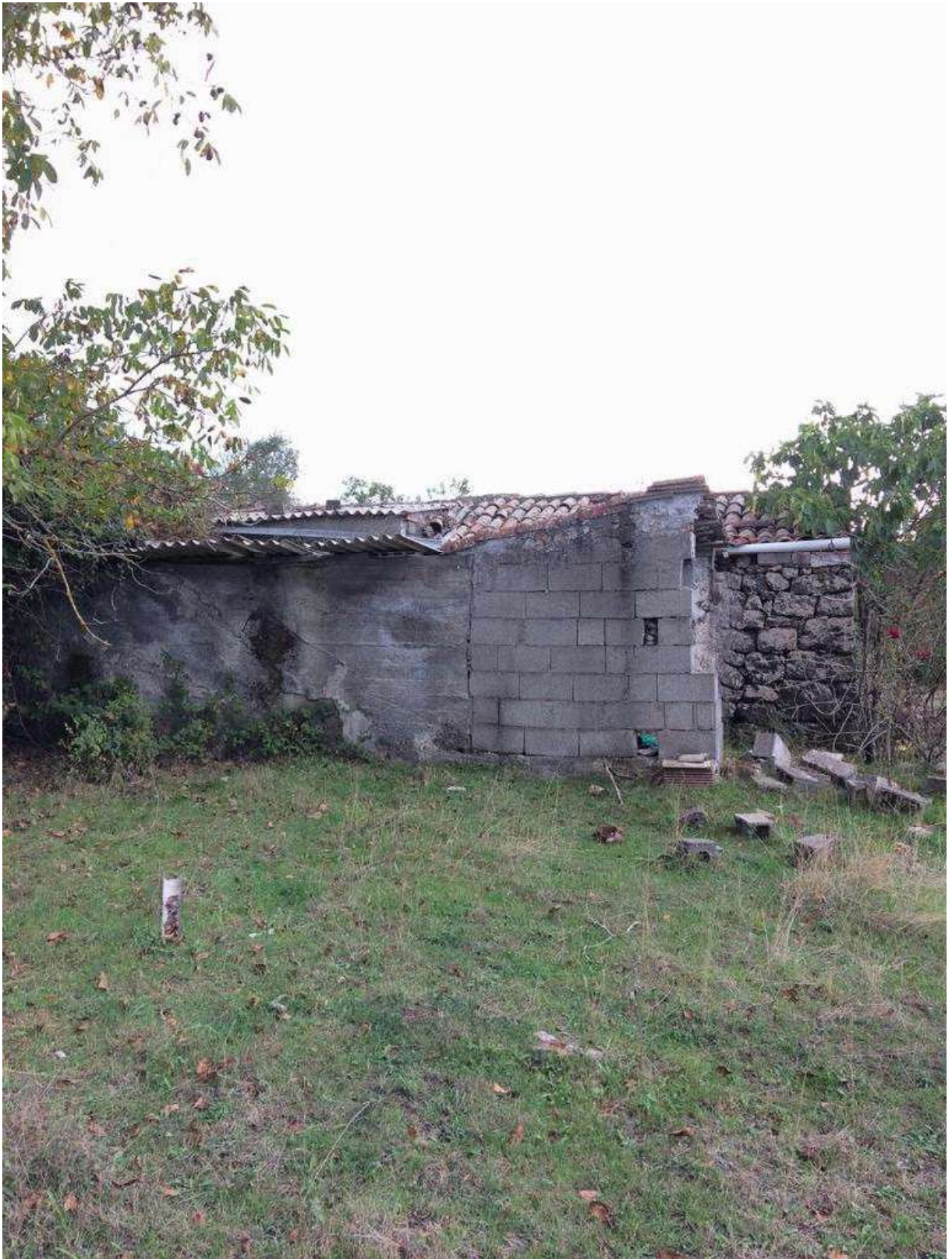
FOTO 8 LOTTO 4 – FABBRICATO RURALE IN CATASTO FABBRICATI FOGLIO 60 P.LLA 438
