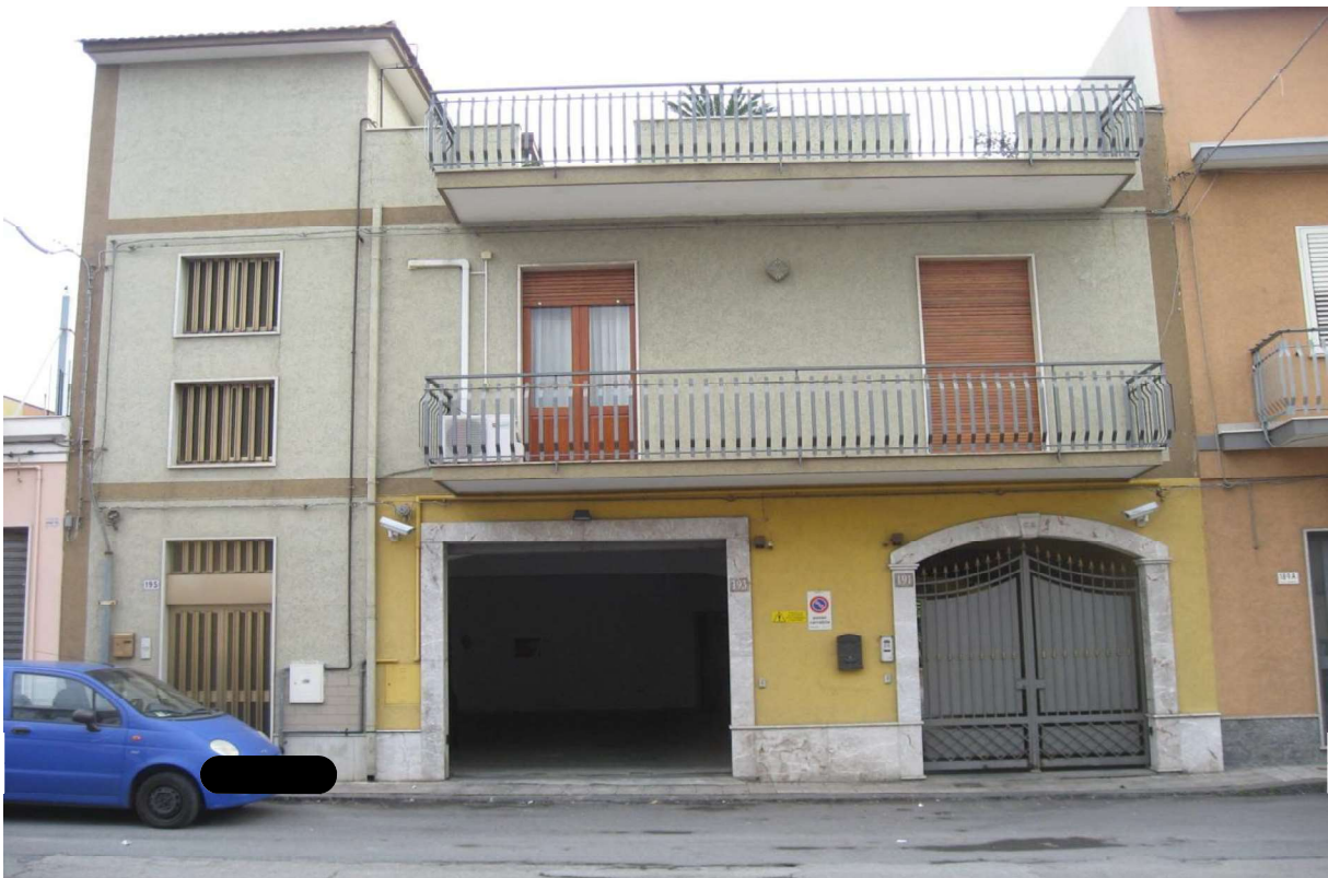
FO L1-2: Prospetto edificio Via San Giuseppe n. 193-191, Mascali.
