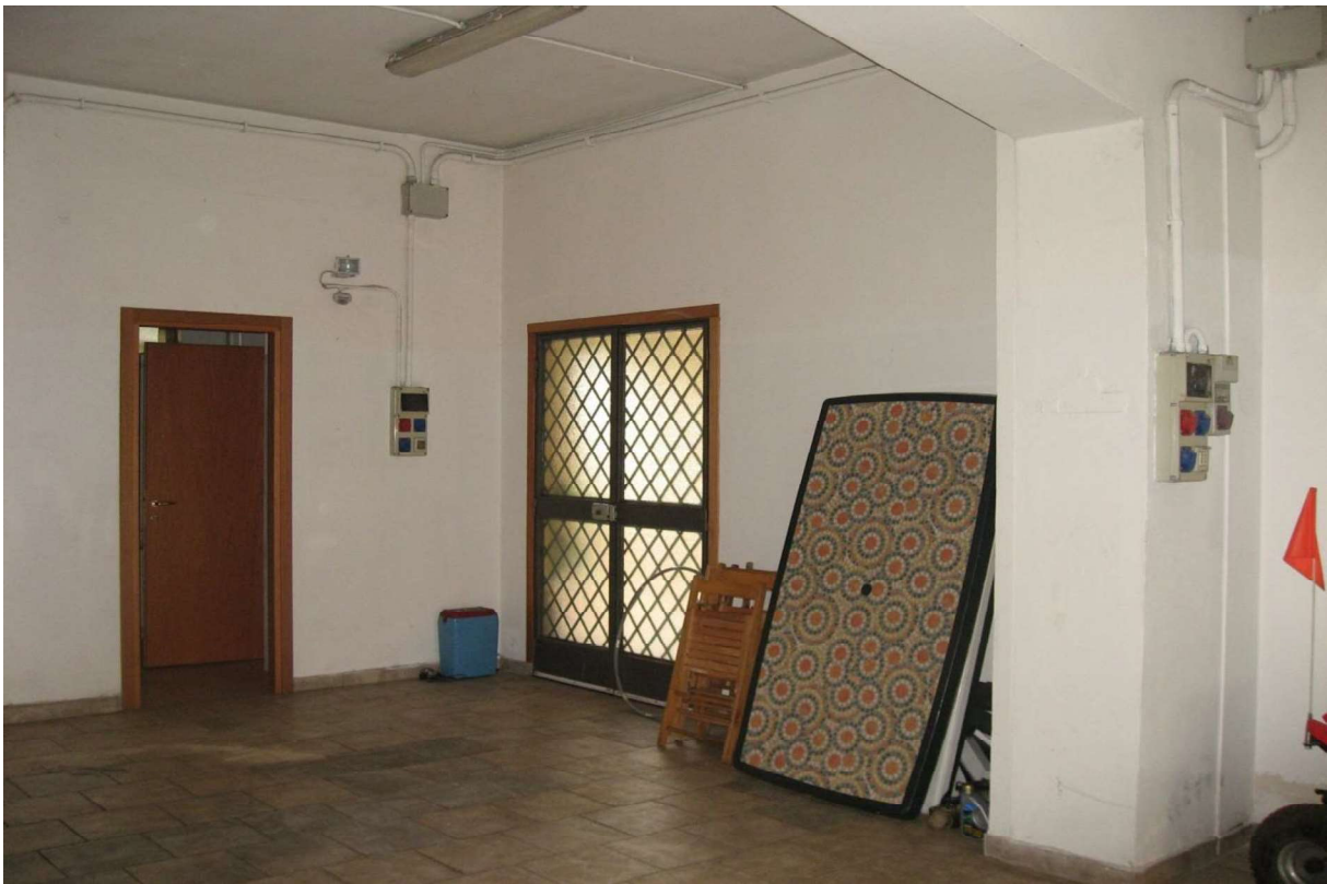
FO L1-6: Interni magazzino, portone di collegamento al portico.
