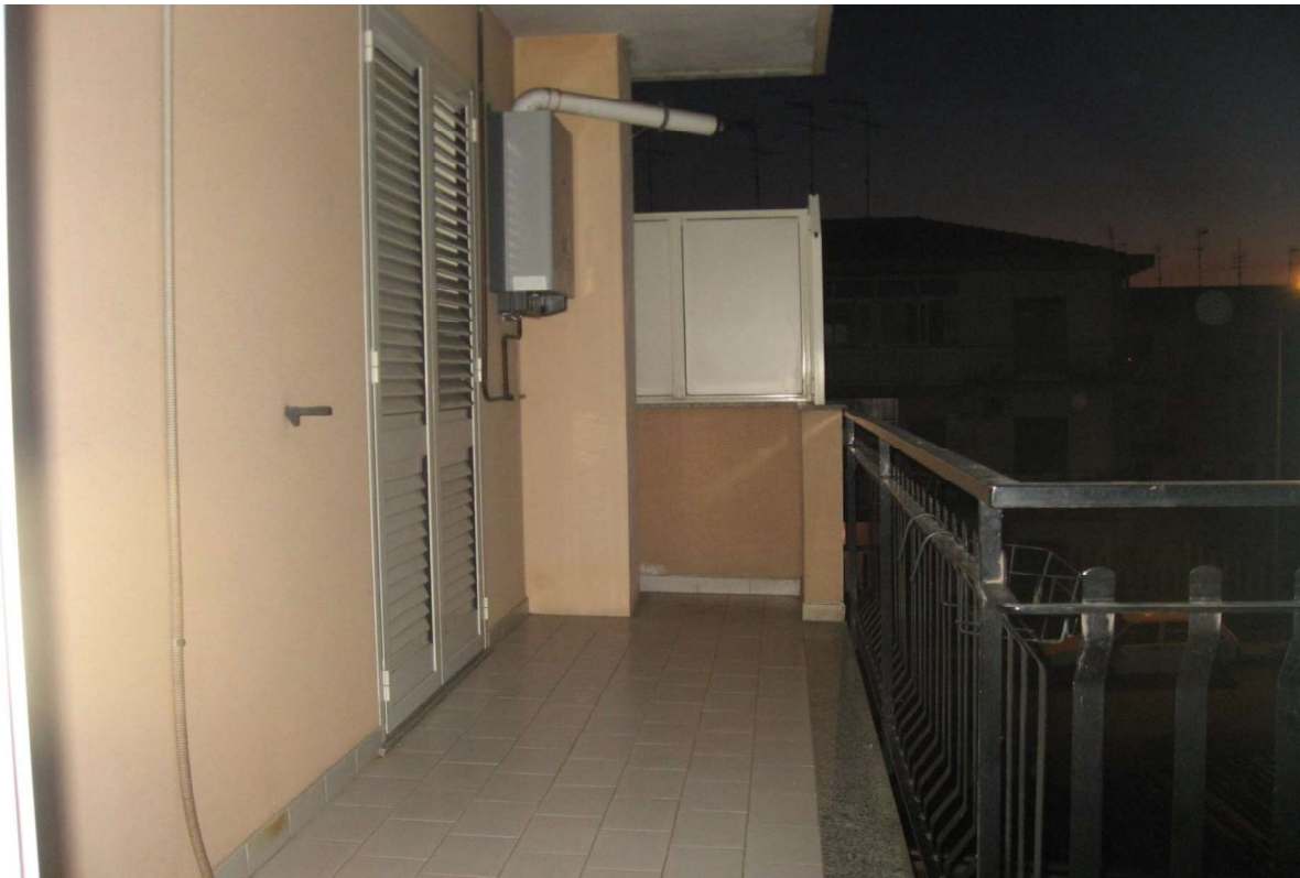
FO L2-26: Balcone al piano primo.
