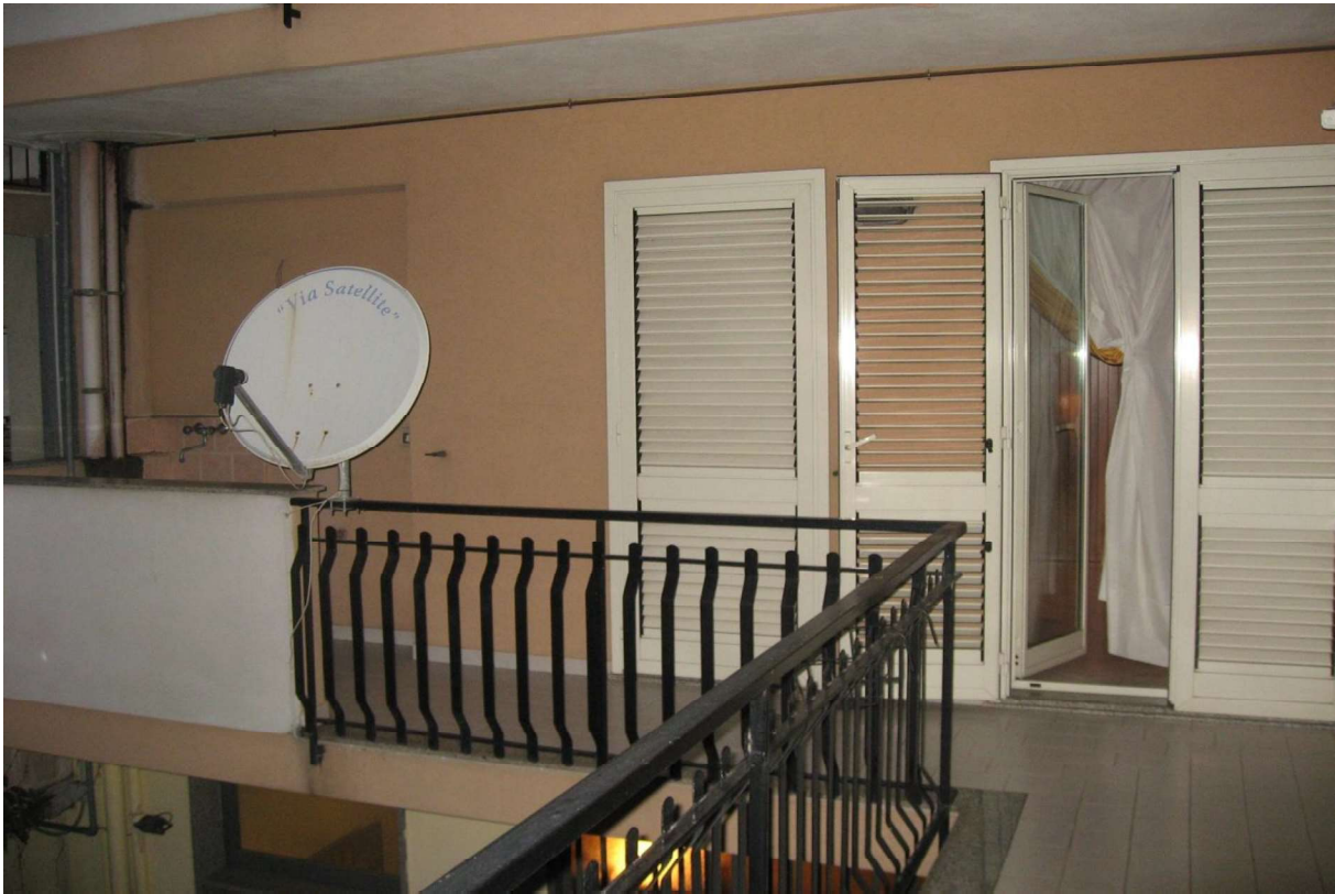
FO L2-25: Balcone al piano primo.
