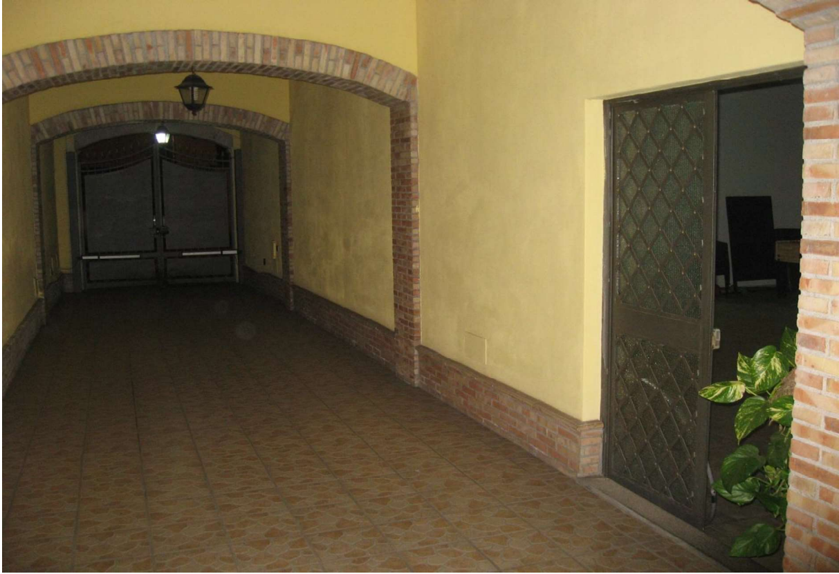
FO L2-2: Portico d'accesso alla corte; a dx portone di collegamento al LOTTO 1.
