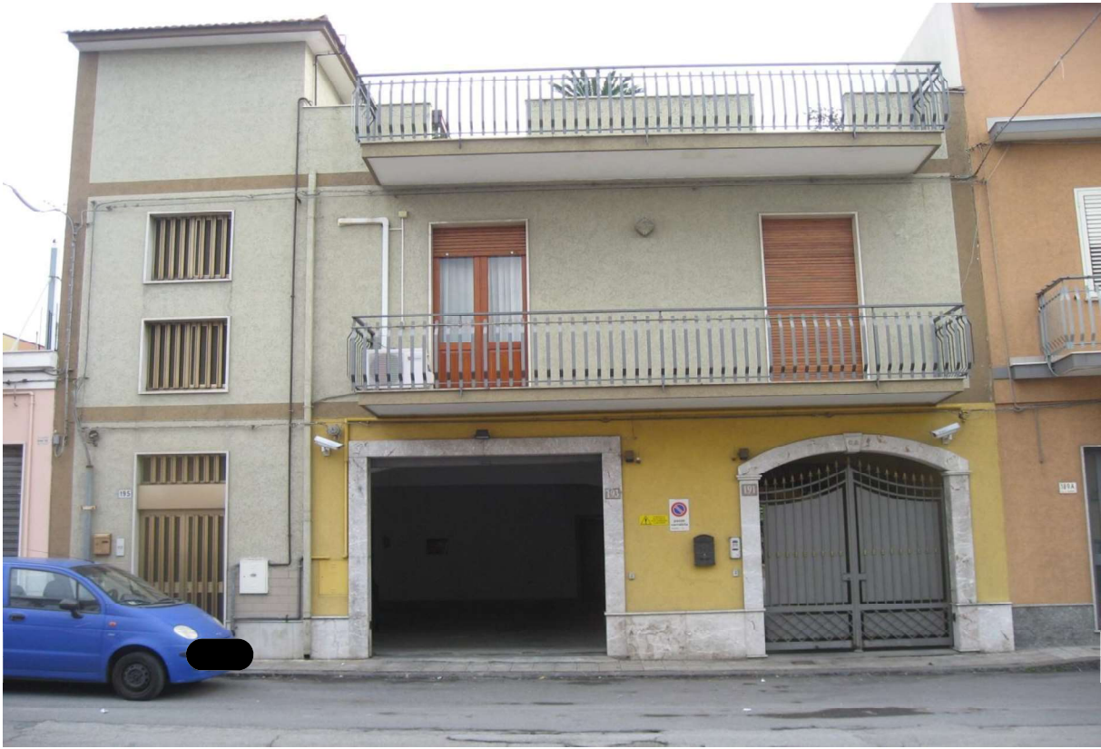
FO L2-1: LOTTO II – Portone lato dx, civ. 191, ingresso al portico.
