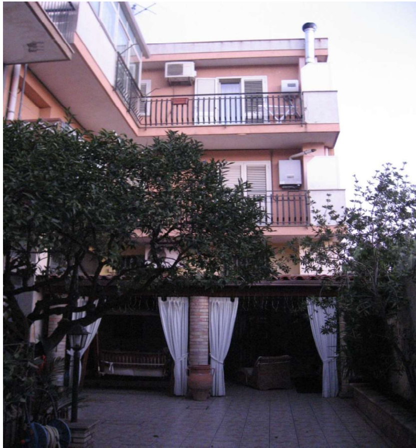
FO L2-7: Corte di pertinenza, prospetto edificio e patio al p.t.
