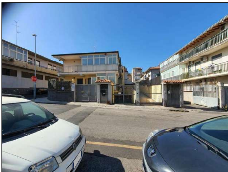
FOTO 1 (Prospetto principale su Via G. Tomasi di Lampedusa)
