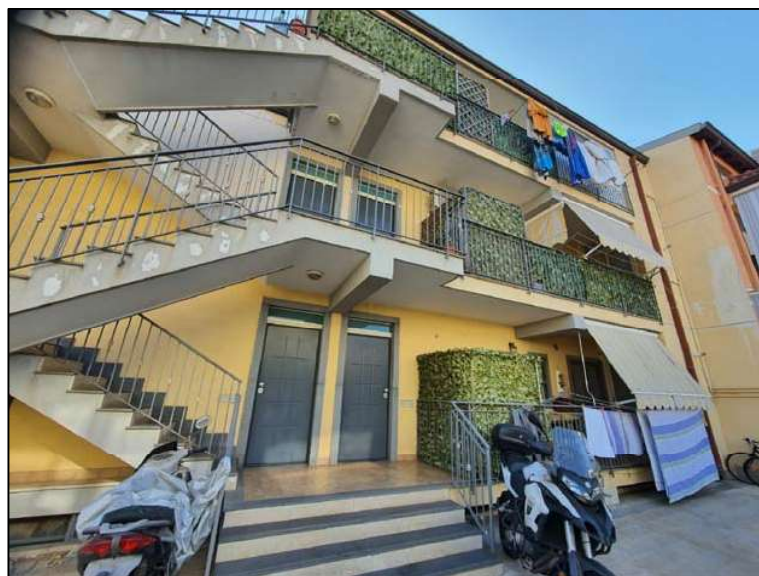
FOTO 4 (Prospetto interno con vano scala esterno)
