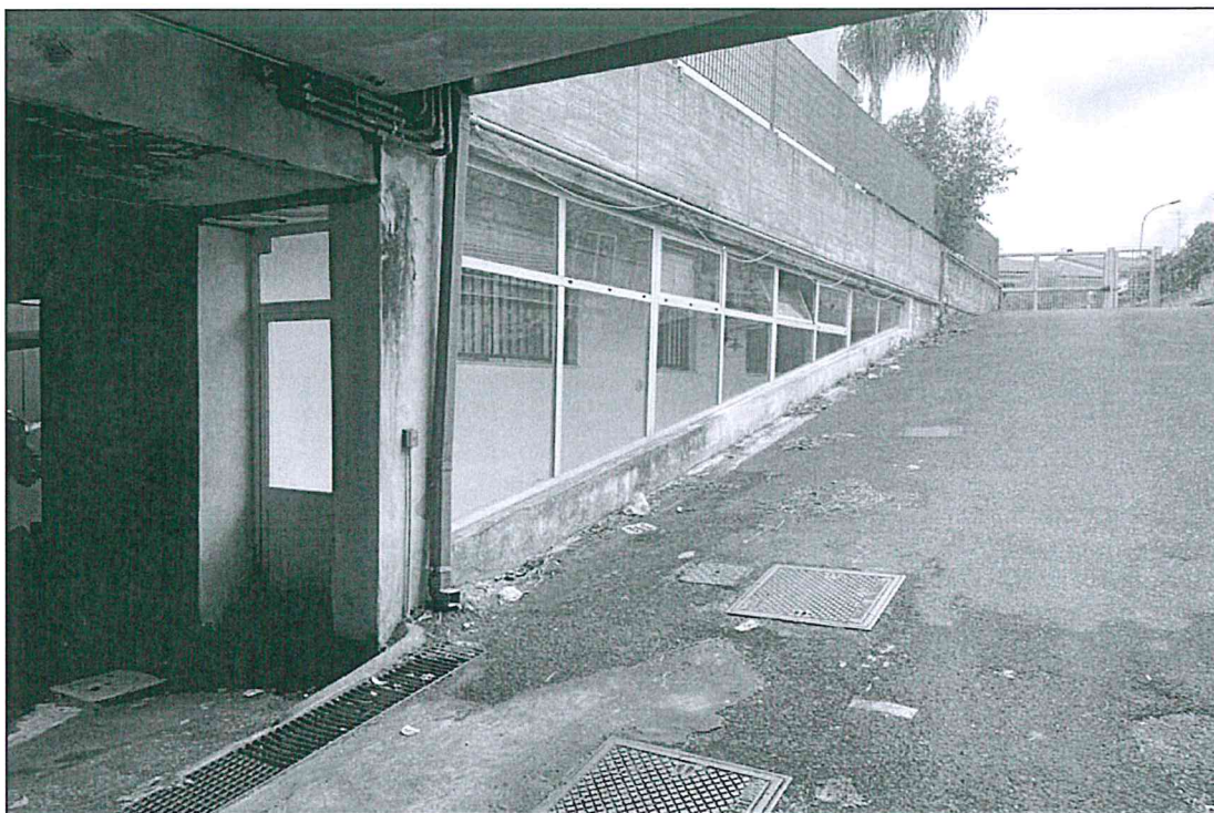
Foto n.12 - Piano cantinato immobile pignorato confinante con rampa di accesso
