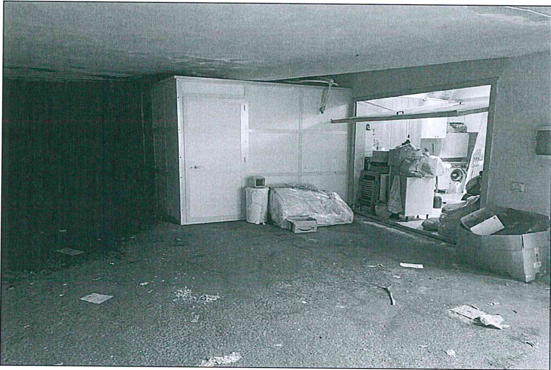
Foto n.13 - Accesso locage garage piano cantinato
