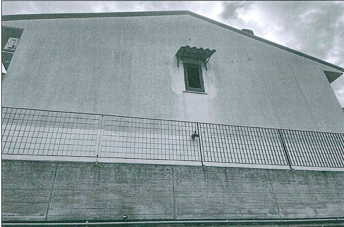
Foto n.11 - Prospetto nord su rampa di accesso al piano cantinato
