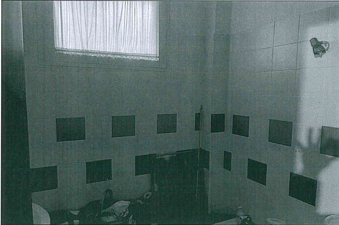
Foto n.19 - Locale bagno piano cantinato
