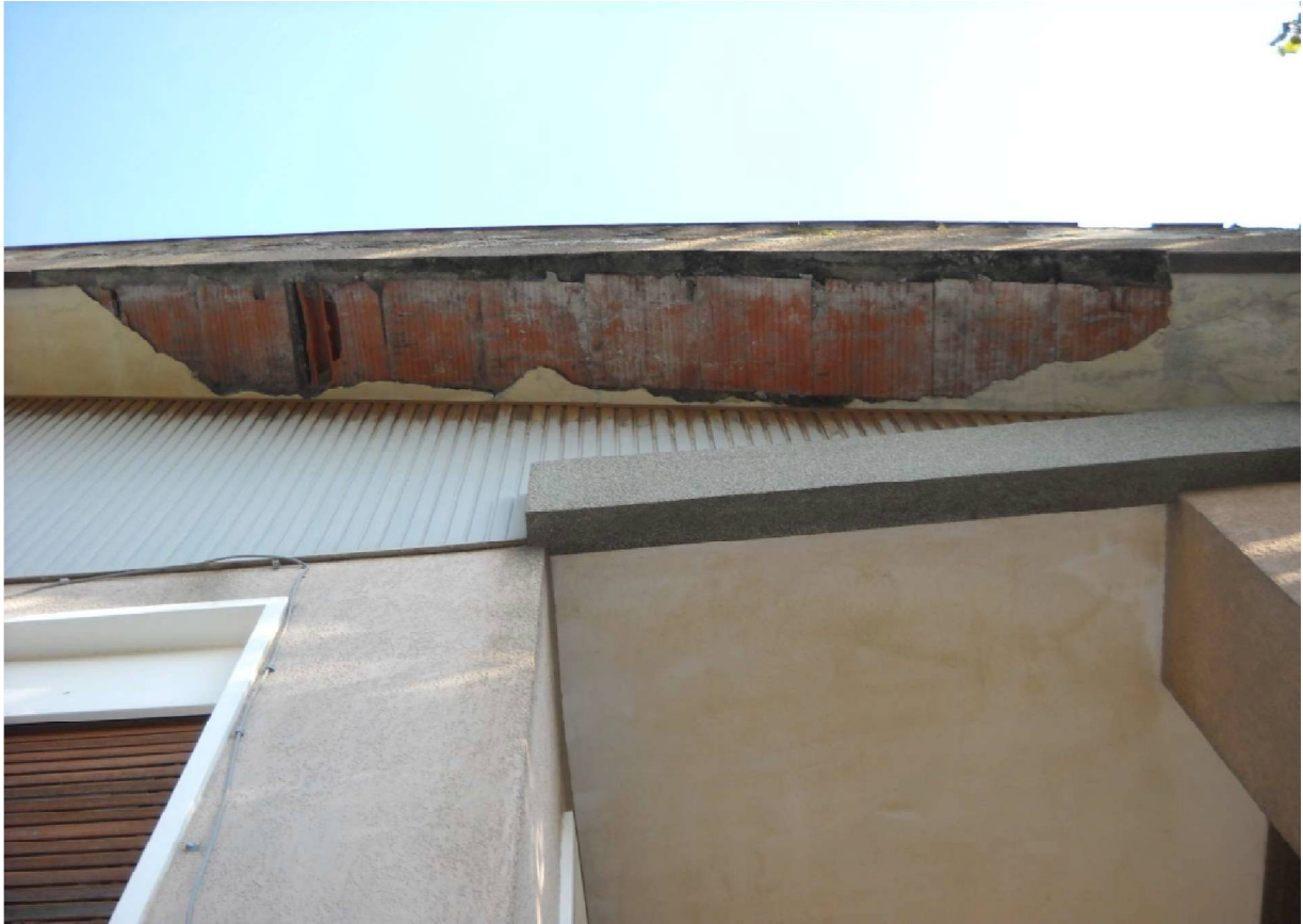
Foto 31. Vista dello stato di conservazione del sottotetto
