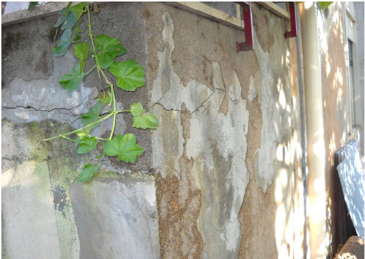
Foto 34. dettaglio dello stato di conservazione delle strutture murarie
