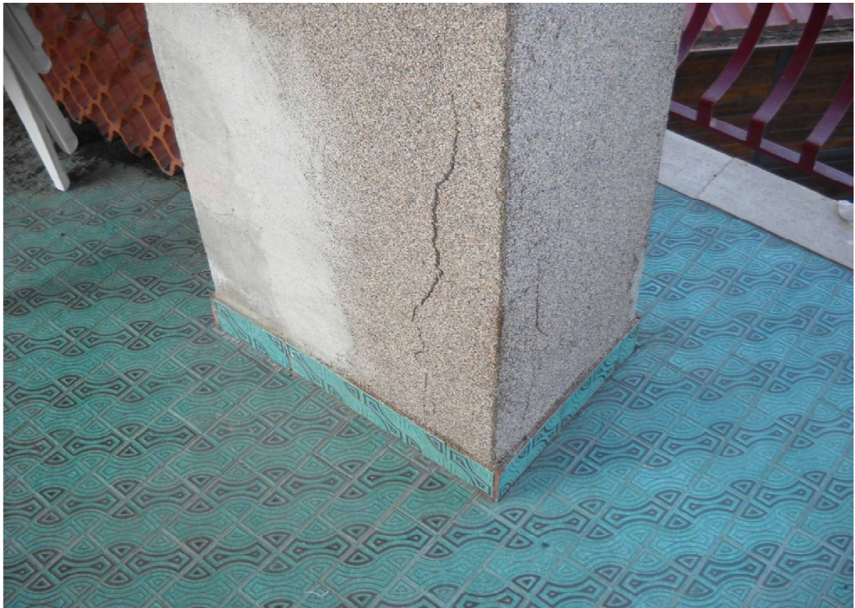
Foto 33. dettaglio dello stato di conservazione delle strutture murarie
