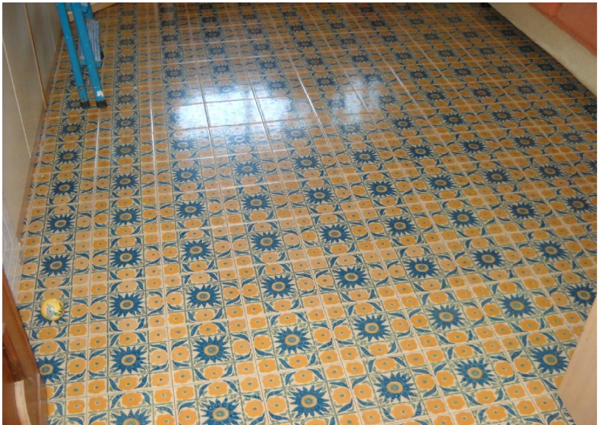
Foto 22. Dettaglio del pavimento presente nel secondo vano
