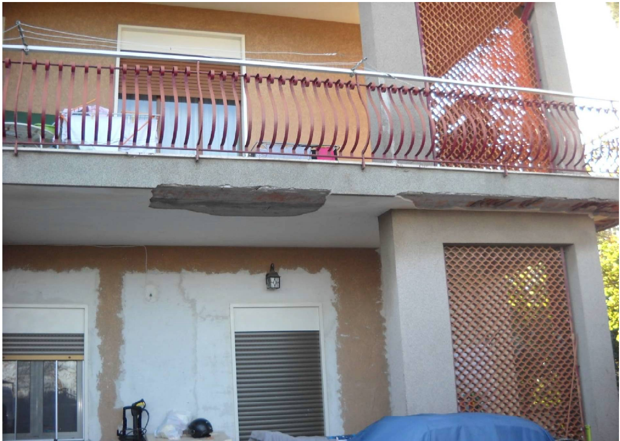
Foto 3. Vista della facciata esterna dell'immobile
