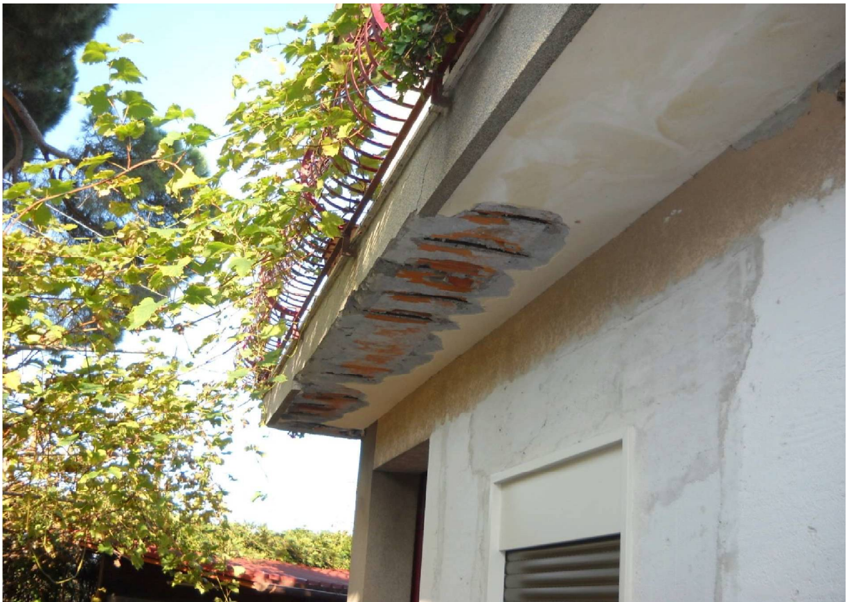
Foto 32. Dettaglio dei sottoballatoi
