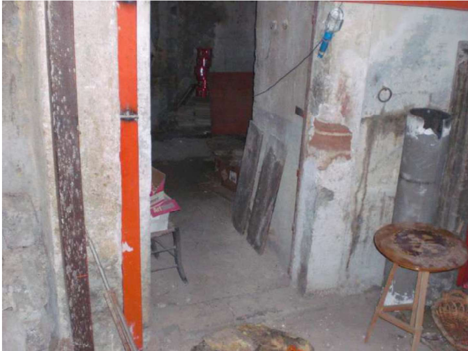
Foto 5 Vista del piano interrato
