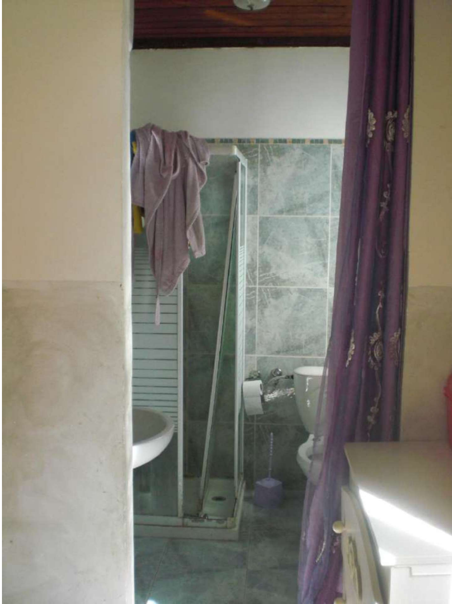
Foto 11 Vista del bagno del piano primo
