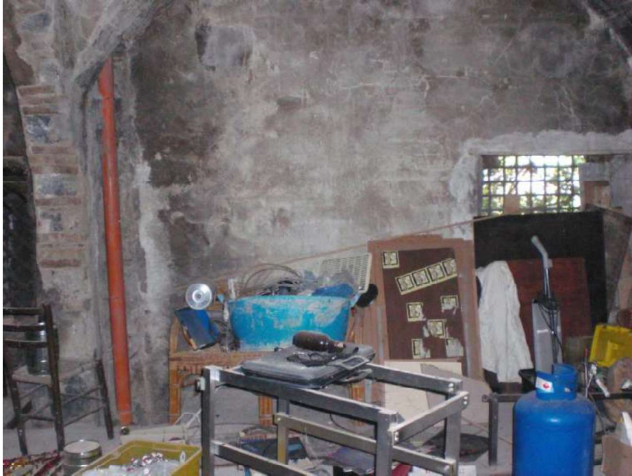
Foto 4 Vista del terzo ambiente del piano terra
