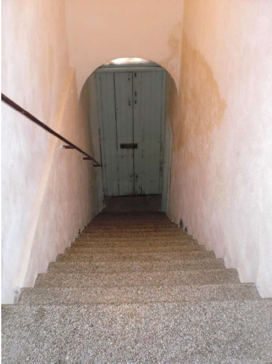
Foto 6 Vista della scala che porta al piano primo
