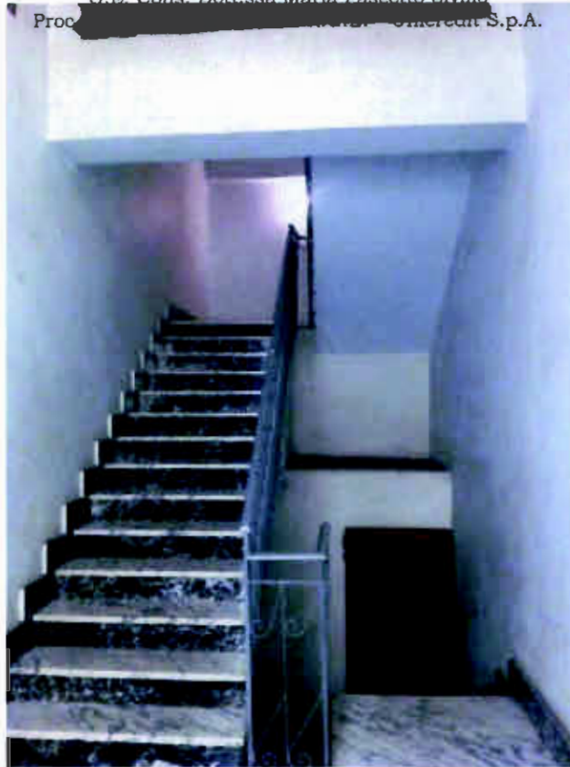
FO-3 (Vano scala)
