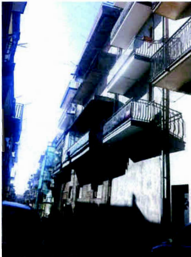
FO-14 (Prospetto su Via Massimo D'Azeglio con veduta della veranda al piano primo)
