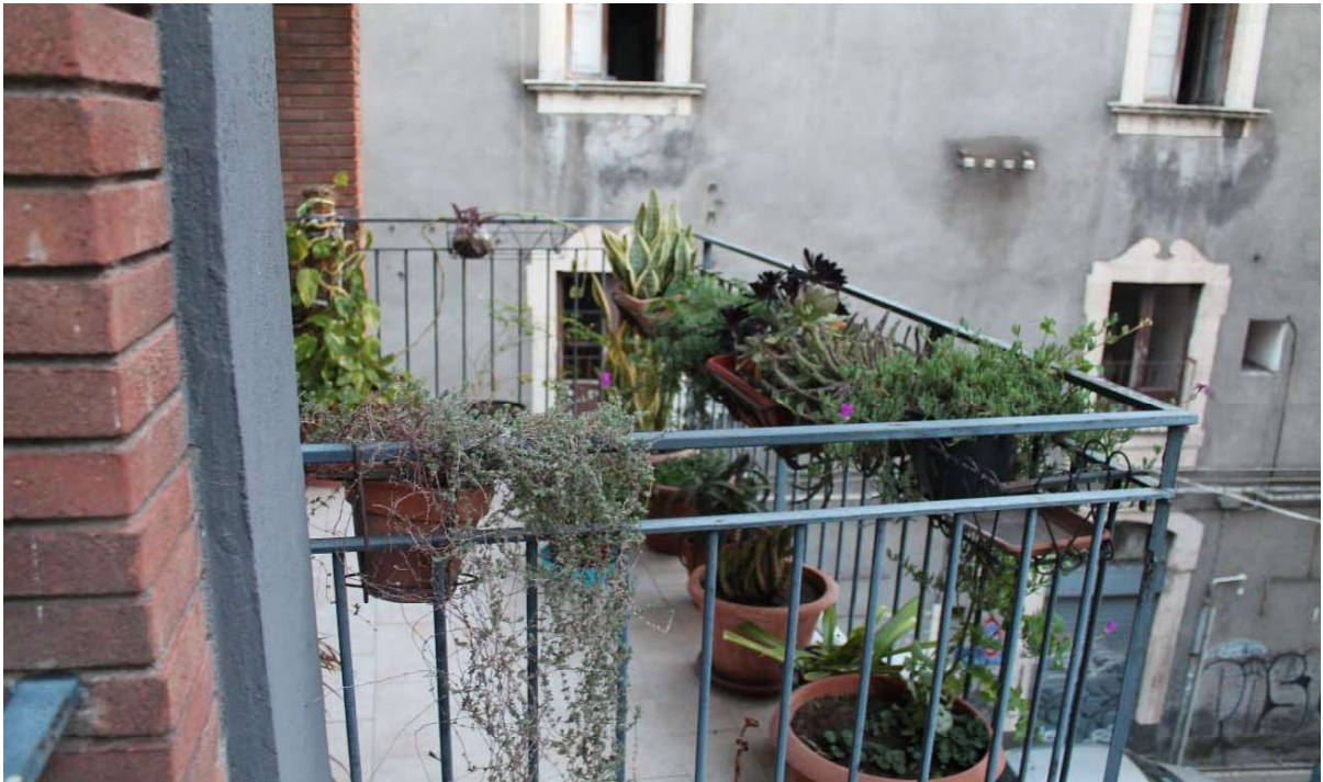
FOTO N. 27 – VANO 3 – BALCONE SU VIA LOGGETTA
