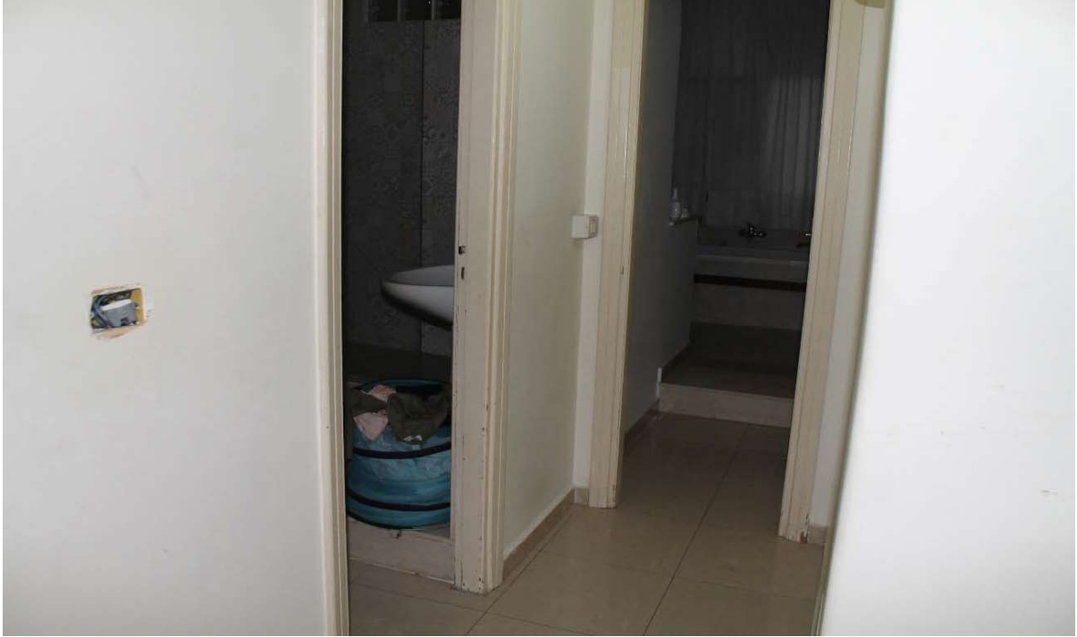
FOTO N. 34 – DISIMPEGNO – VISTA ANGOLO SERVIZI
