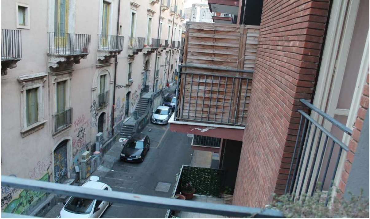
FOTO N. 18 – VANO 1 BALCONE VIA LOGGETTA – VISTA OPPOSTA
