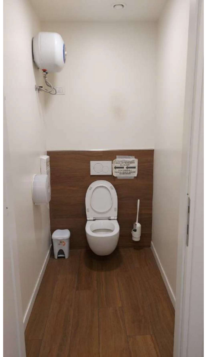
Foto 65. Piano primo - bagno
