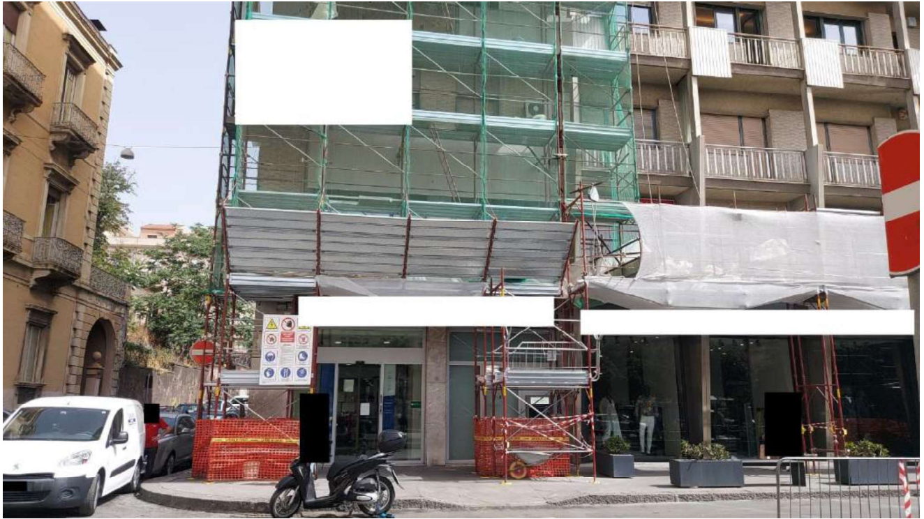
Foto 48. Vista esterna del palazzo da Piazza Trento
