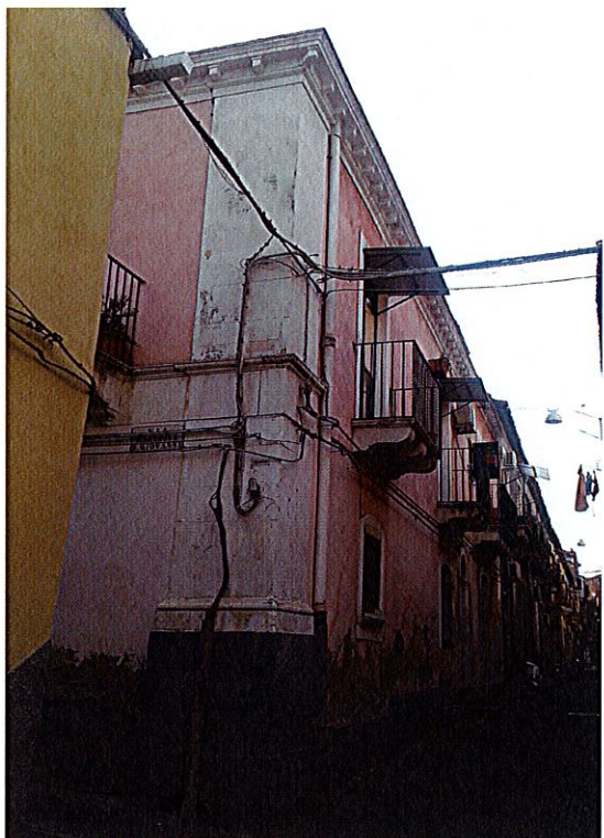
Foto n. 1 – Vista dei prospetti
