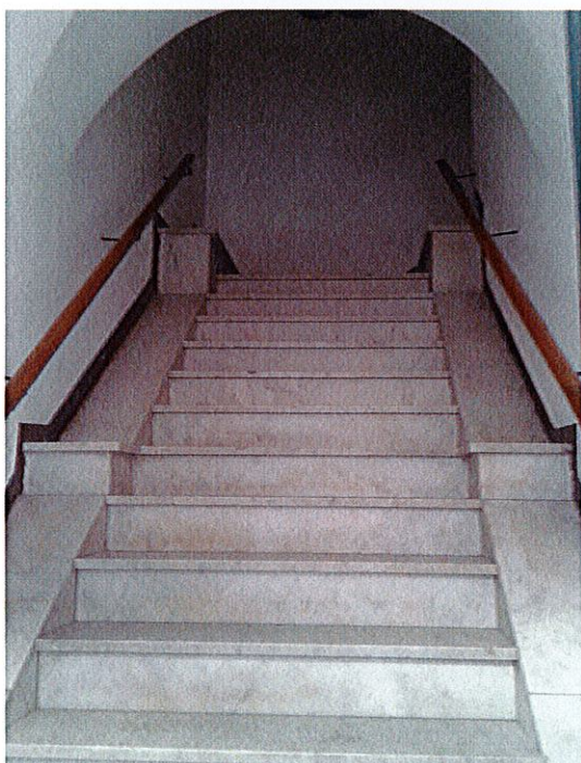
Foto n. 7 – Vista interna della scala comune
