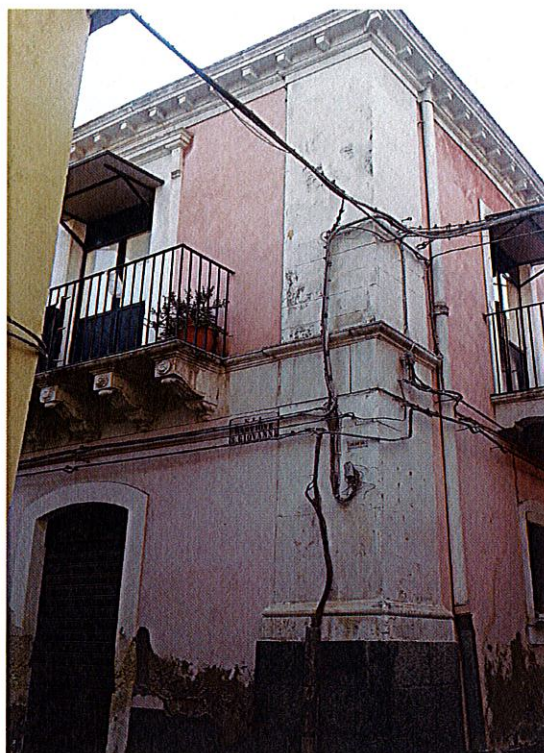
Foto n. 2 – Vista dei prospetti
