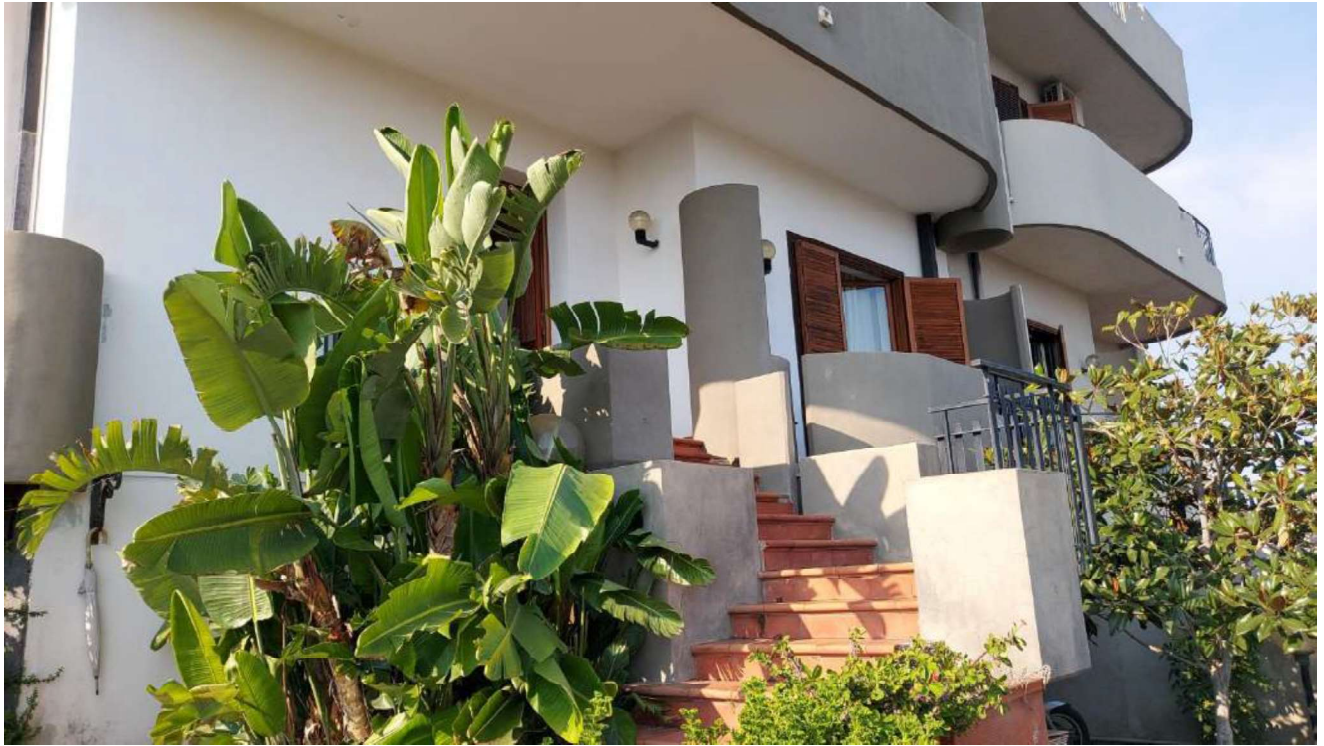
Foto 18. Vista della scala d'ingresso
