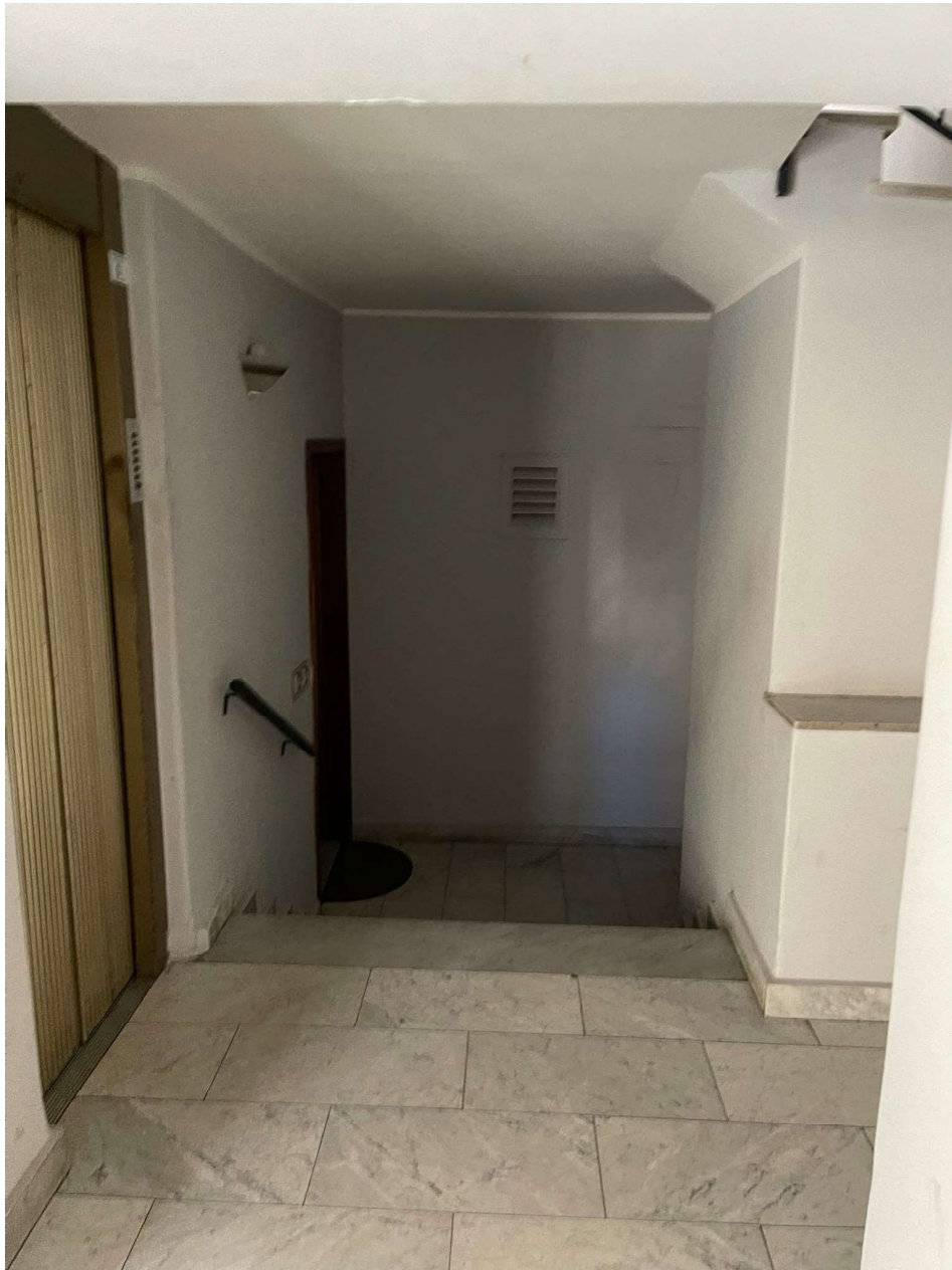
Foto 2 - Vista del vano scale condominiale4
