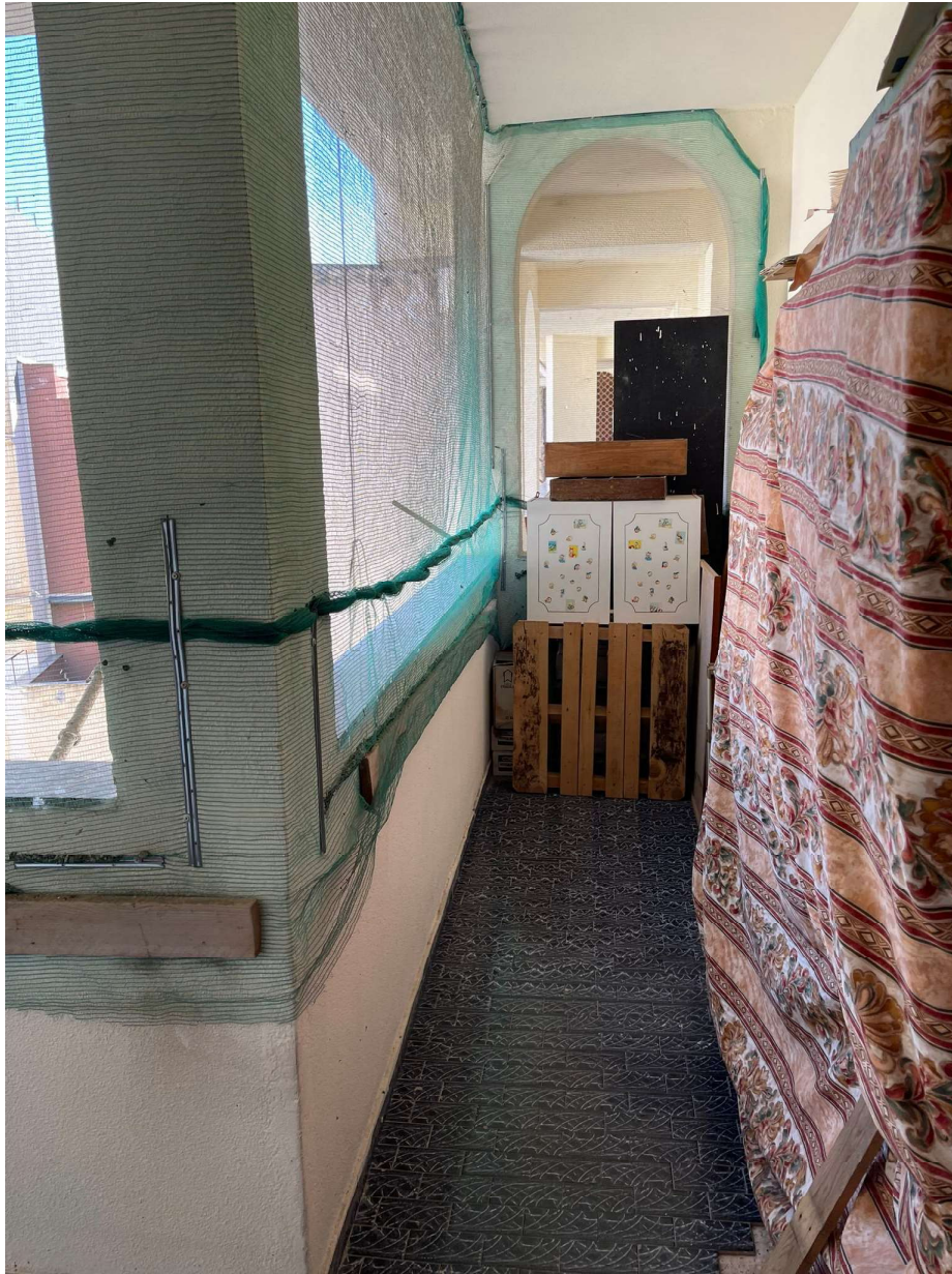
Foto 8 -Vista del balcone fruibile dal salone e cucina
