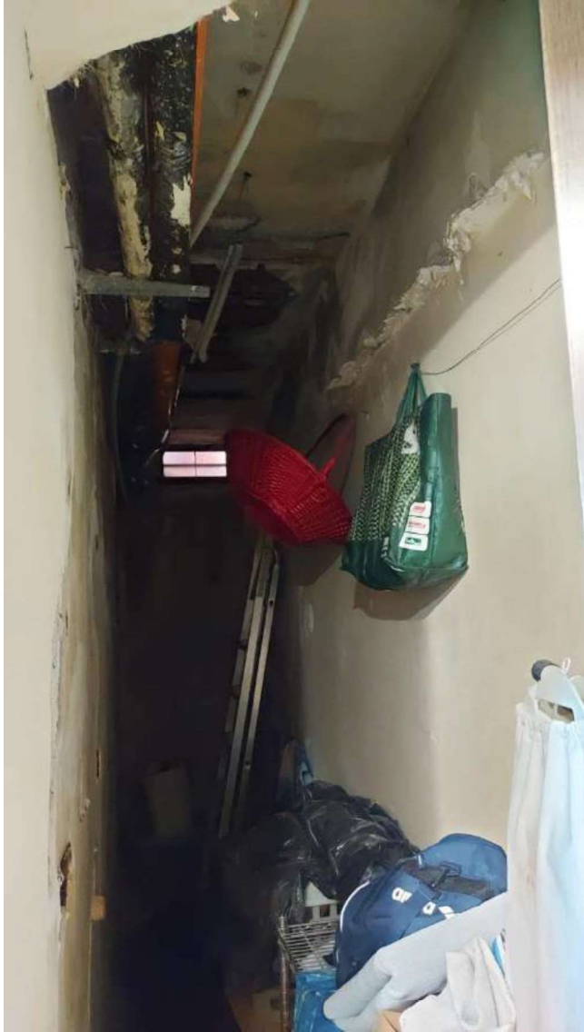
Foto 16. Piano seminterrato - Ripostiglio
