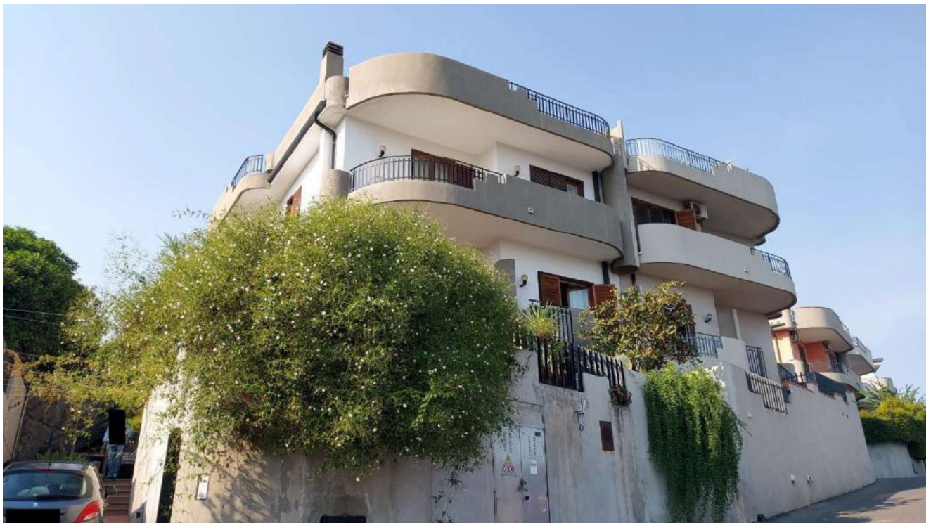
Foto 2. Vista esterna della villetta
