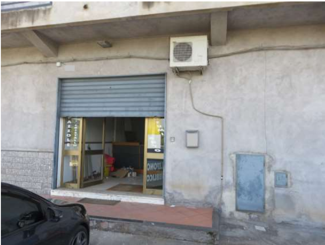
Foto 4 - Accesso all'unità immobiliare
