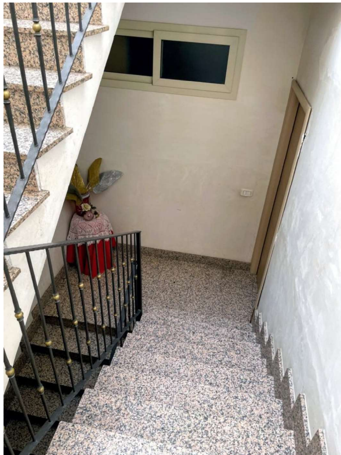
Foto n.4 – Corpo scala dell'edificio in Via Primo Maggio n.7 Adrano
