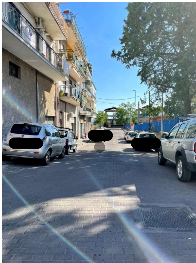
Foto n.2 – Vista della via Primo Maggio- Adrano ove sorge l'edificio
