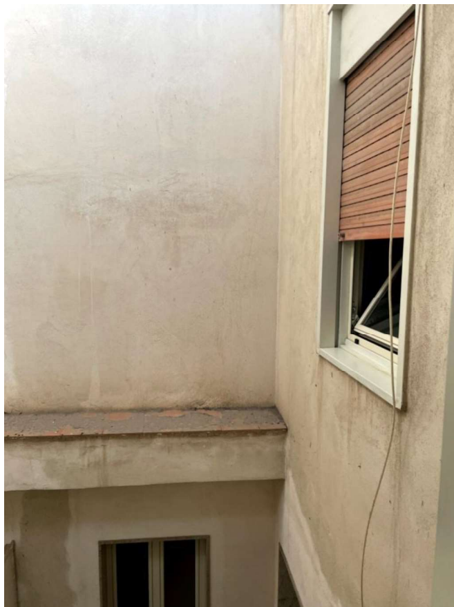
Foto n.21 – Vista verso il pozzo di luce e finestra del bagno
