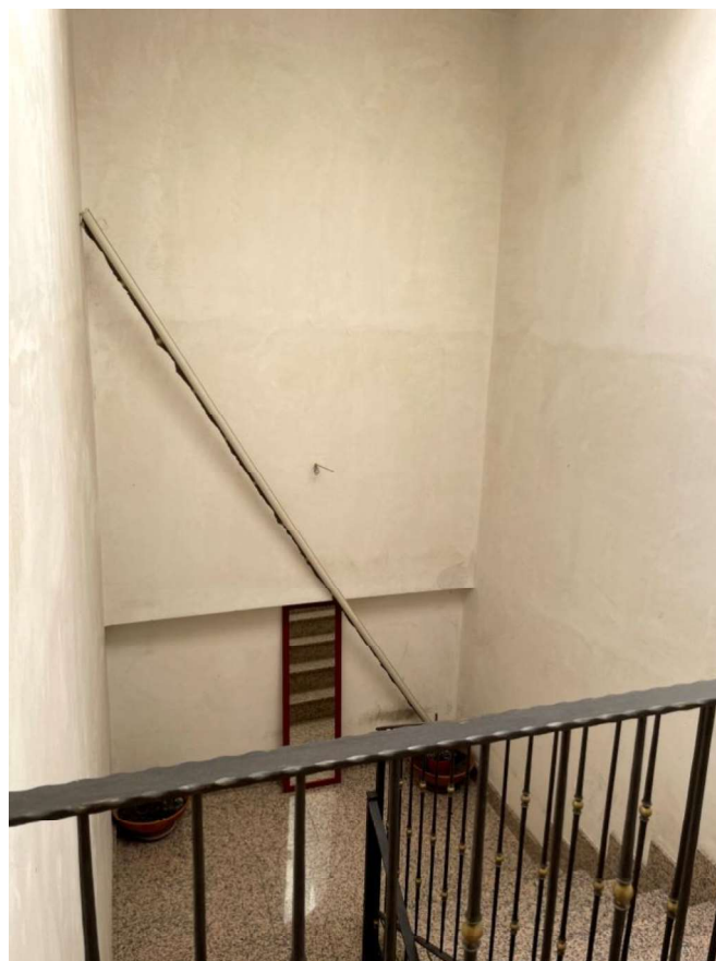
Foto n.5 – Corpo scala dell'edificio in Via Primo Maggio n.7 Adrano
