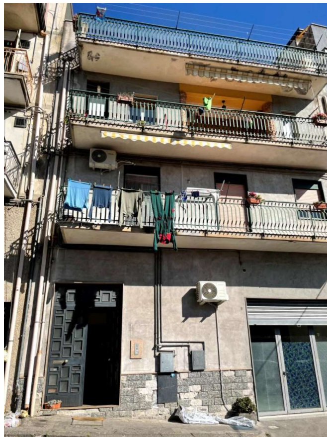
Foto n.1 - Vista esterna dell'edificio in Via Primo Maggio n.7 Adrano
