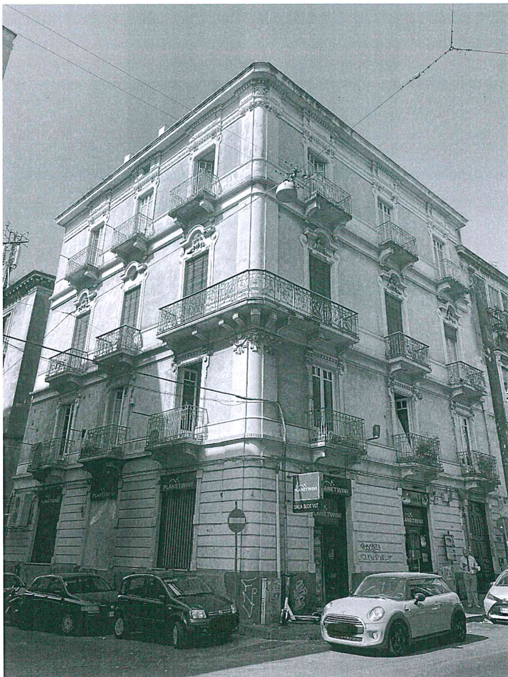
Foto 1 – Prospetto su Viale Vittorio Emanuele e su Via Gagliani
