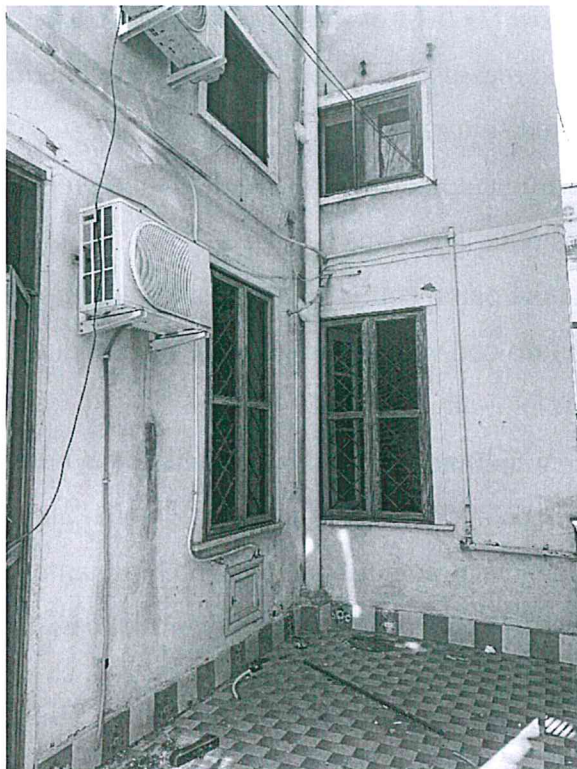
Figura 10 – Terrazza esterna alla cucina
