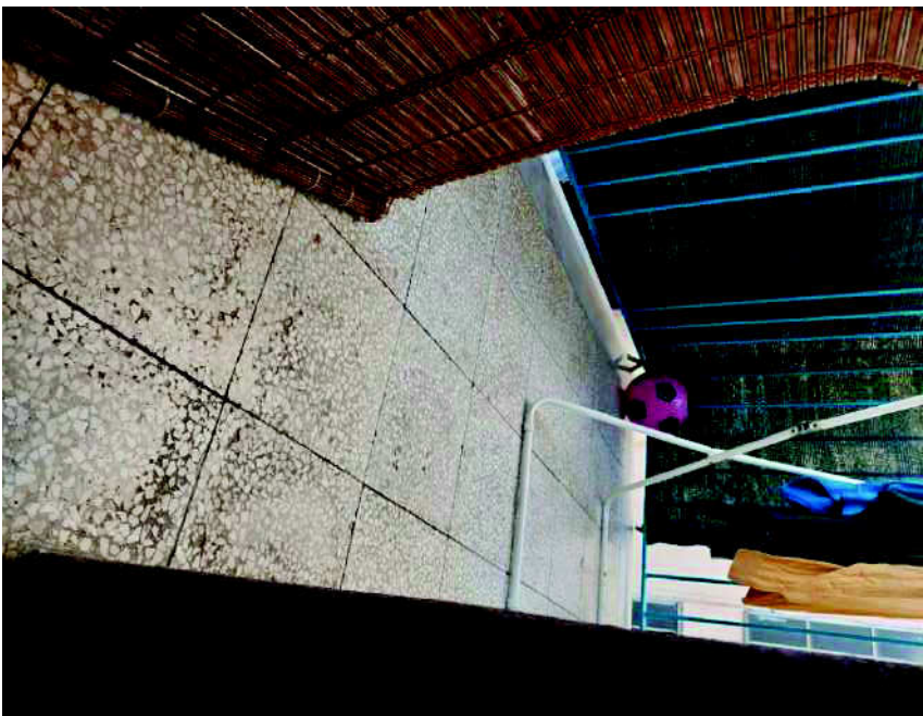
Foto n. 17 Vista del ballatoio della cucina
