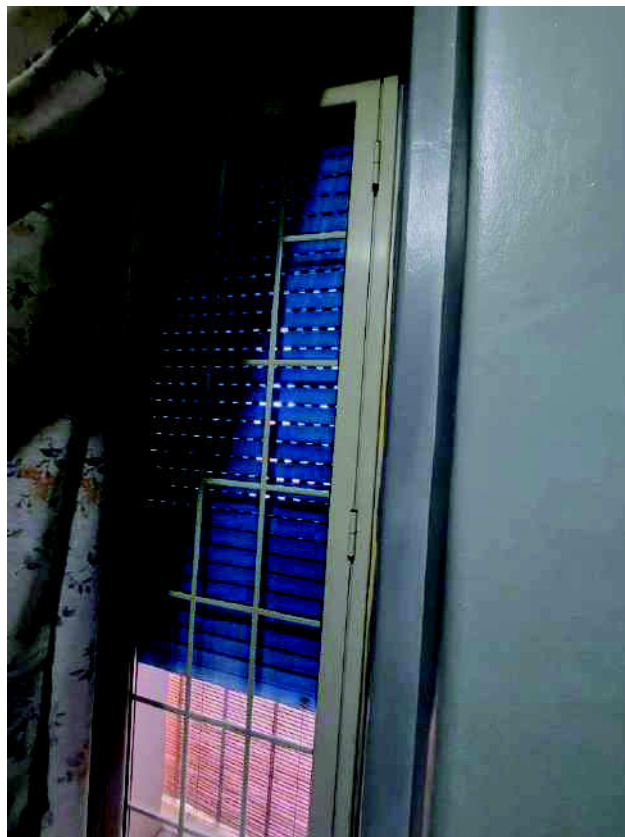
Foto n. 12 Vista della porta finestra d'accesso nel ballatoio della cucina
