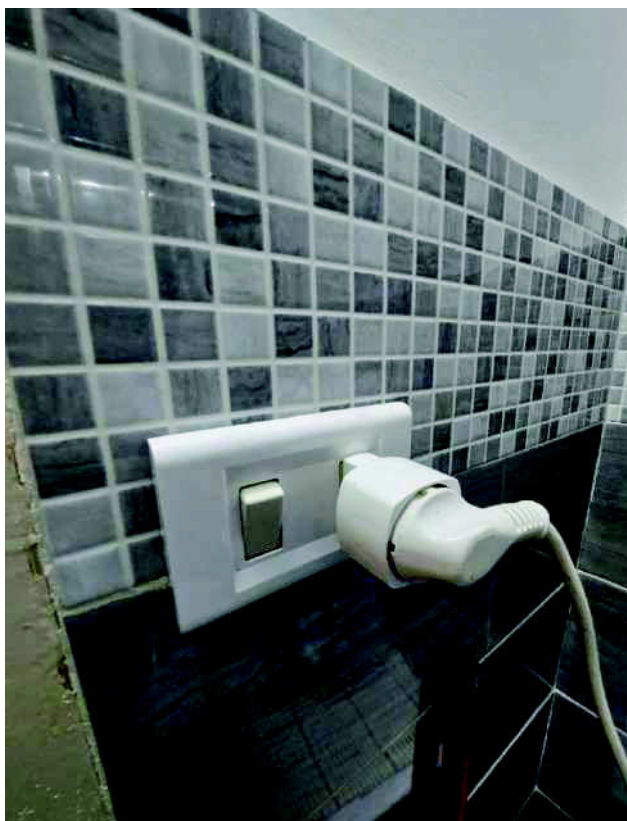
Foto n. 15 Vista della presa elettrica nel bagno
