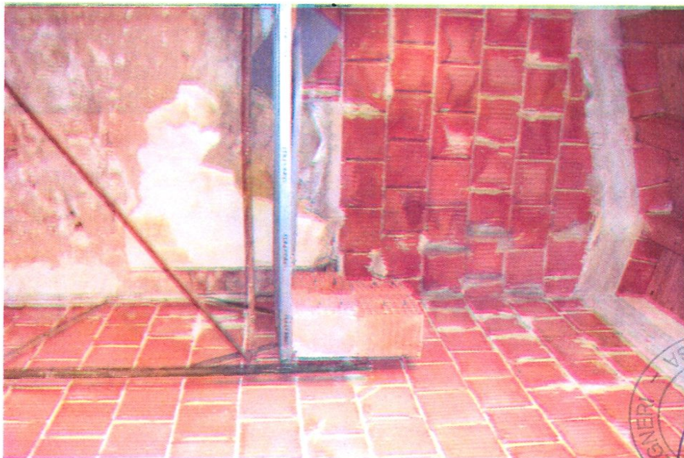
Foto 5 – Vista interna dei vani al piano primo
