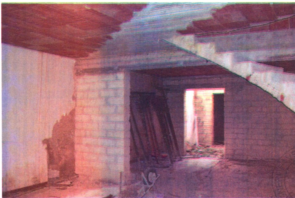
Foto 3 – Vista dell'interno del piano terra con scala
