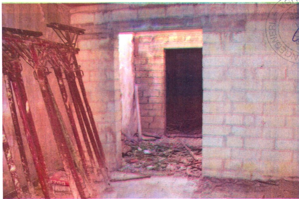
Foto 4 – Vista del pozzo luce al piano terra
