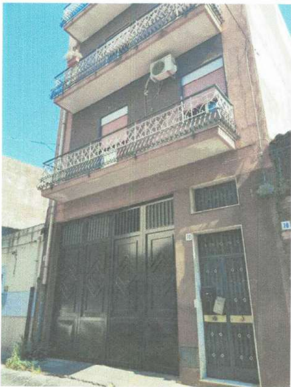
Prospetto su via Galliano
