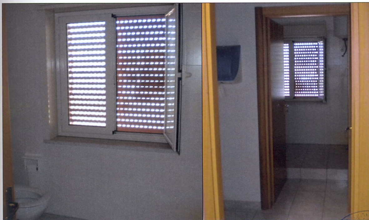
Bagno _ Foto n. 21
