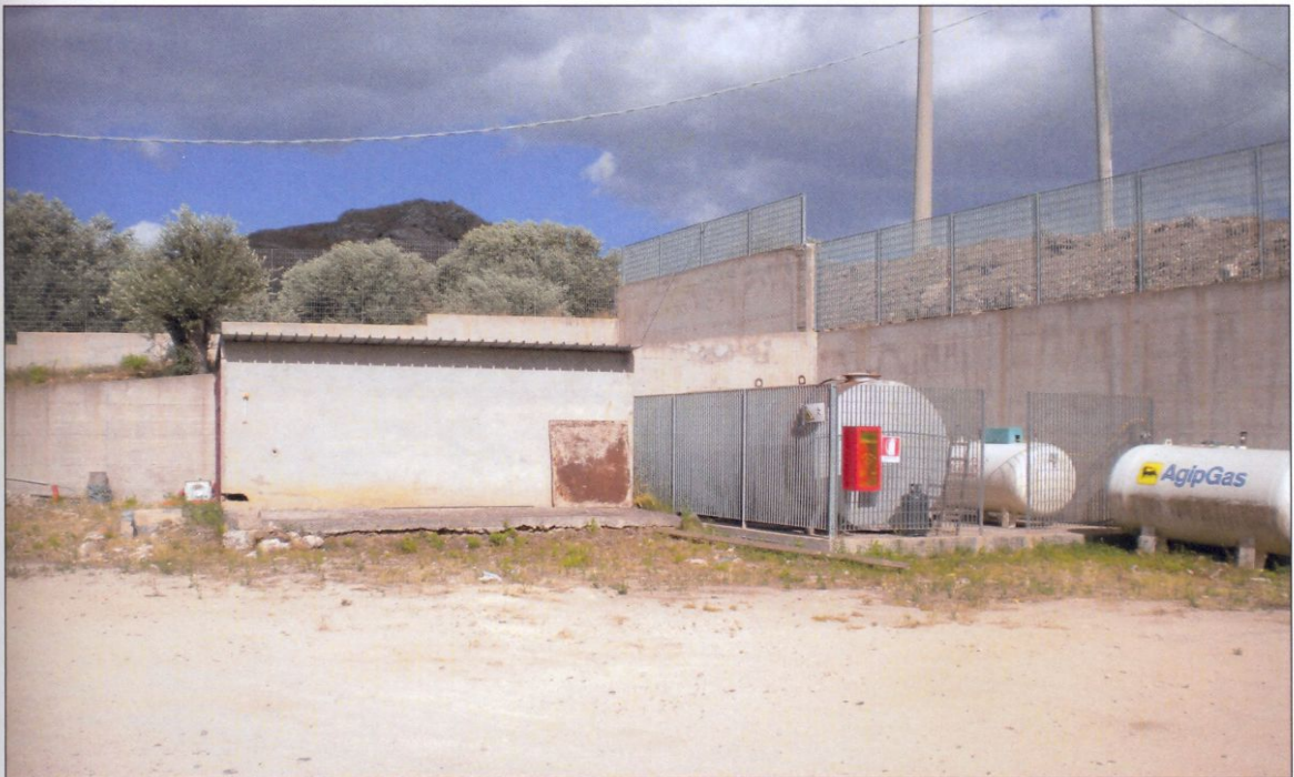
Locali tecnici _ Foto n. 31
