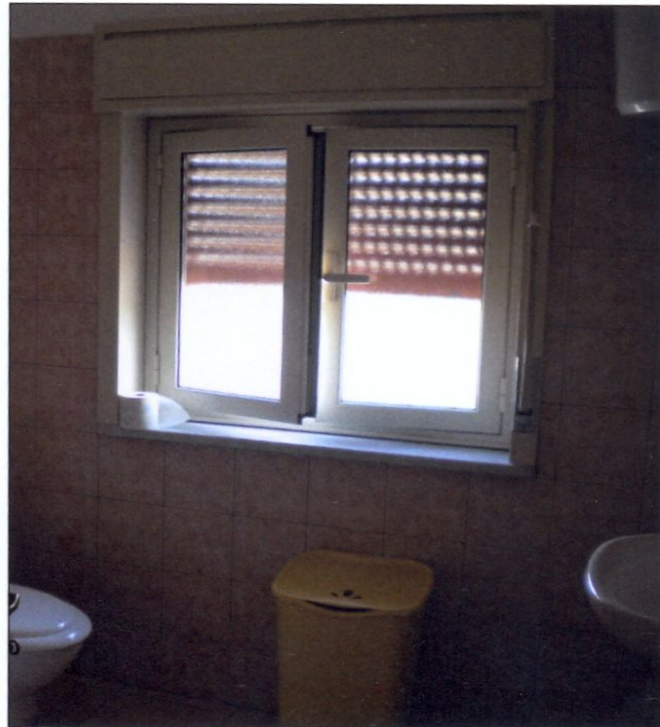
Ripostiglio - Bagno _ Foto n. 24
