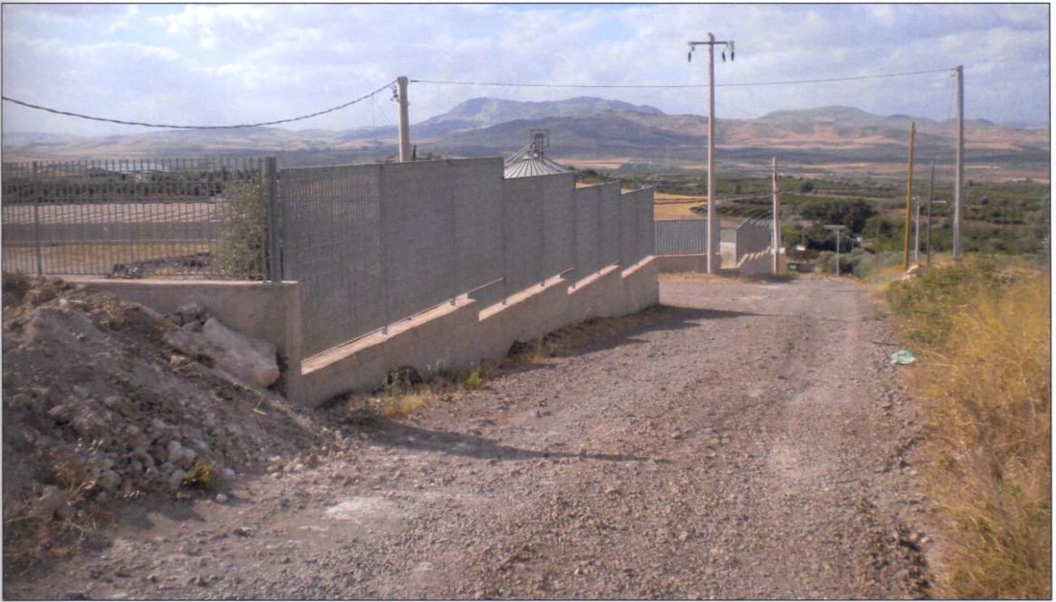
Recinzione esterna _ Foto n. 30
