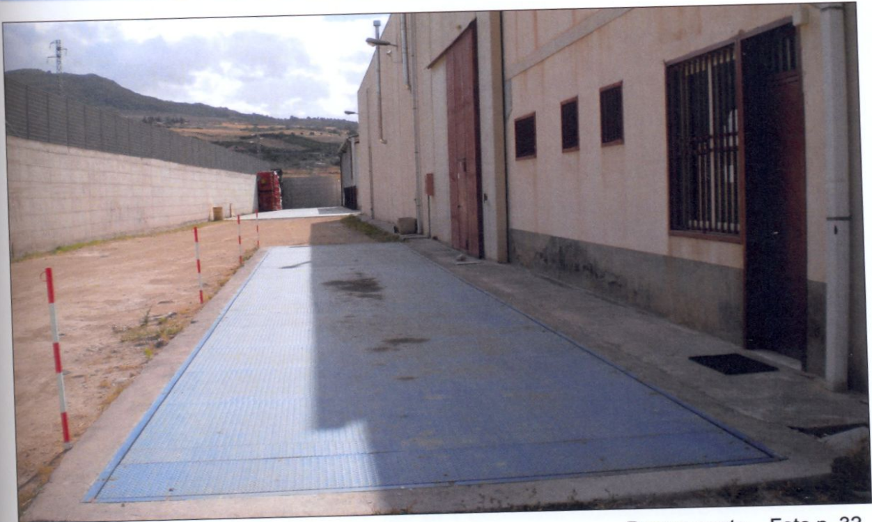
Pesa a ponte _ Foto n. 32
