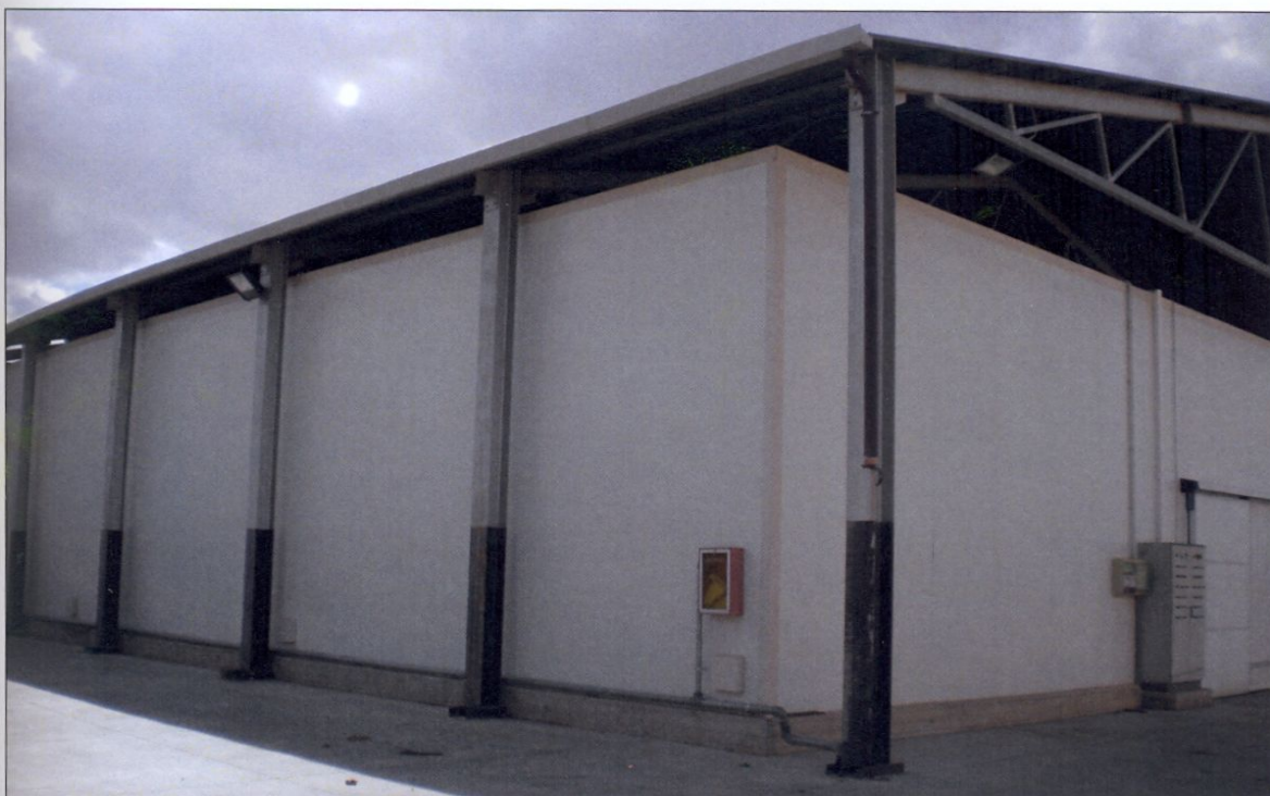
Copertura esterna celle frigorifere _ Foto n. 27
