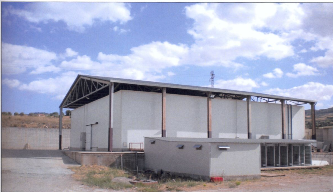
Copertura esterna celle frigorifere _ Foto n. 26
