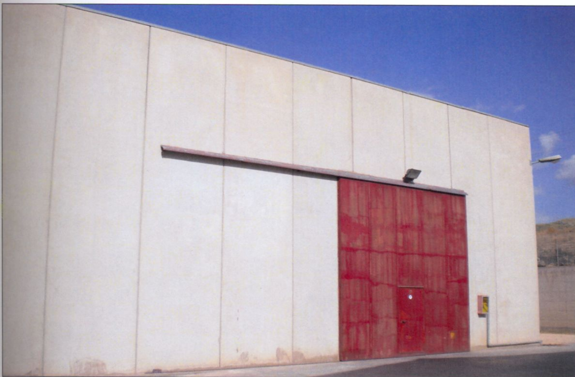
Prospetto posteriore _ Foto n. 6
