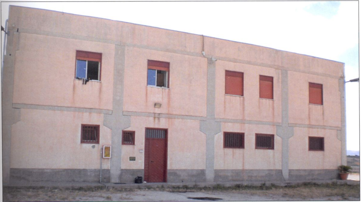
Prospetto principale _ Foto n. 3
