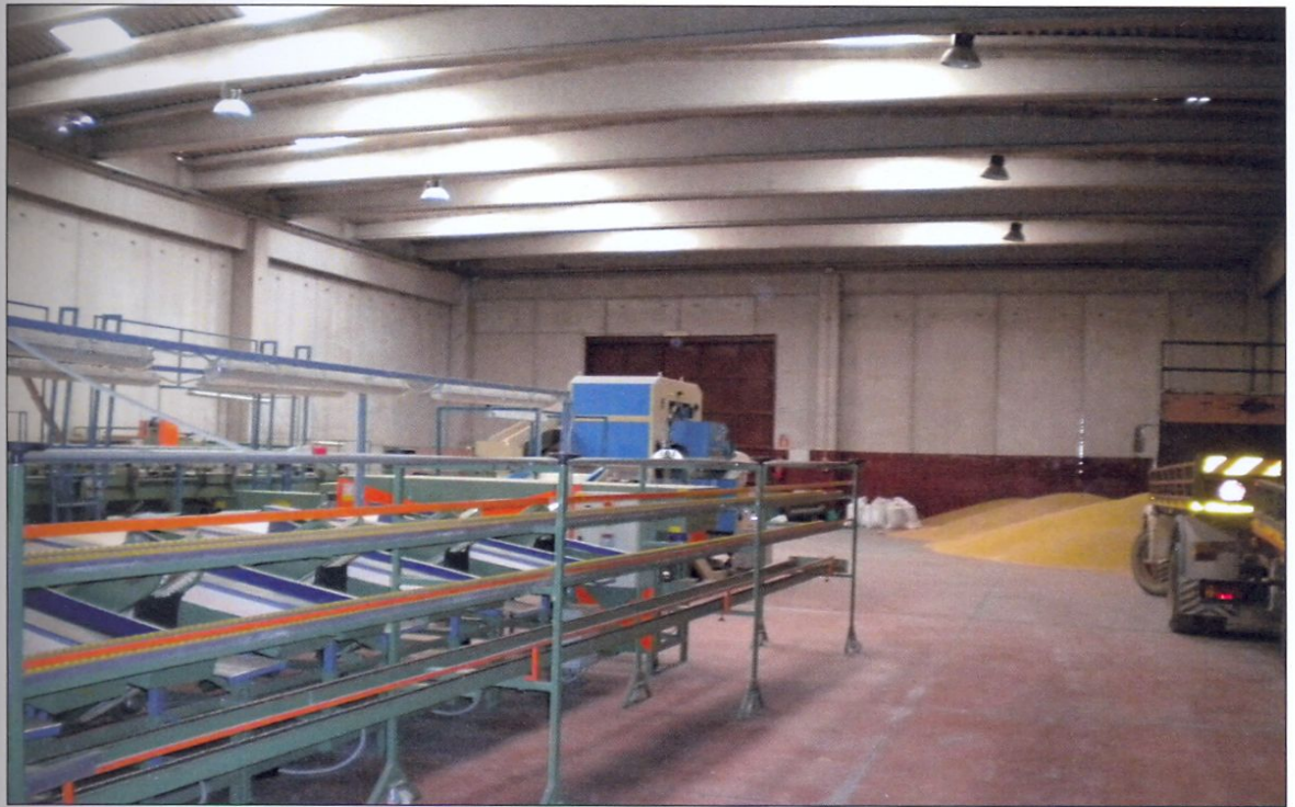
Zona lavorazione _ Foto n. 13
