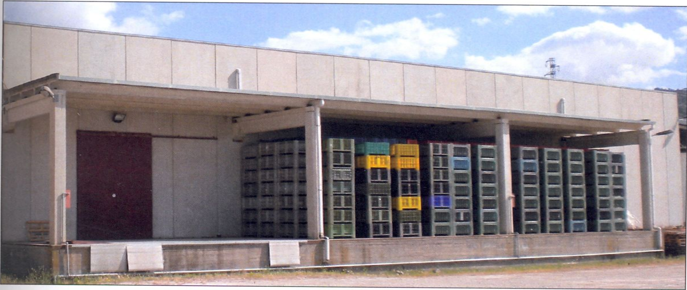
Locale di carico _ Foto n. 15
