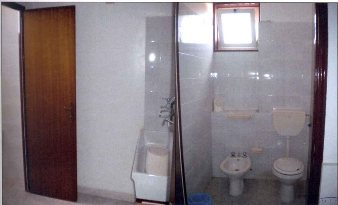
Spogliatoi - Bagni _ Foto n. 8
