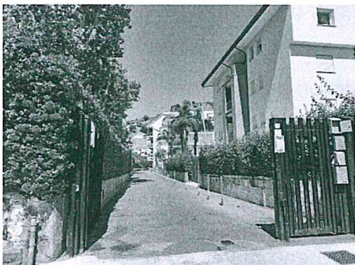
Viale di accesso da Via Trifilò Soldato
