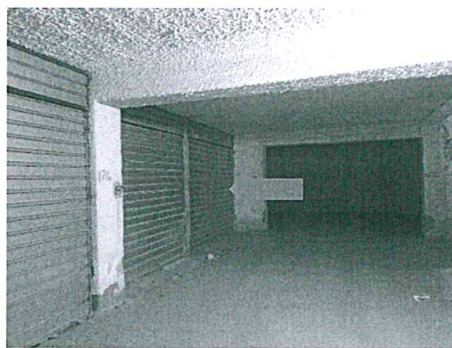
Vista dell'immobile in oggetto (box n° 176)
