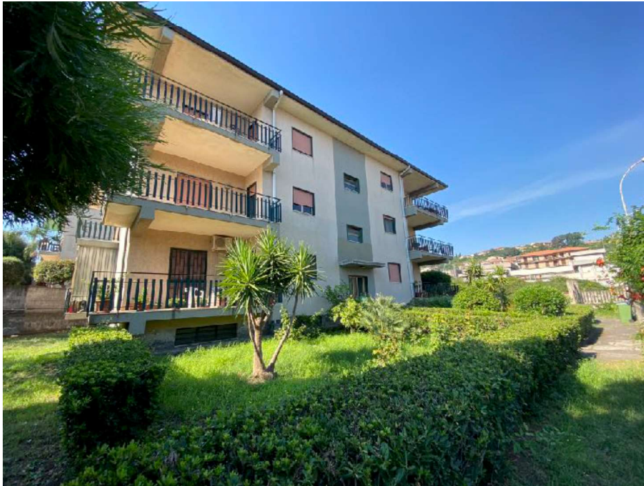
foto 6 - la palazzina B vista dall'angolo Nord-Est della corte condominiale
