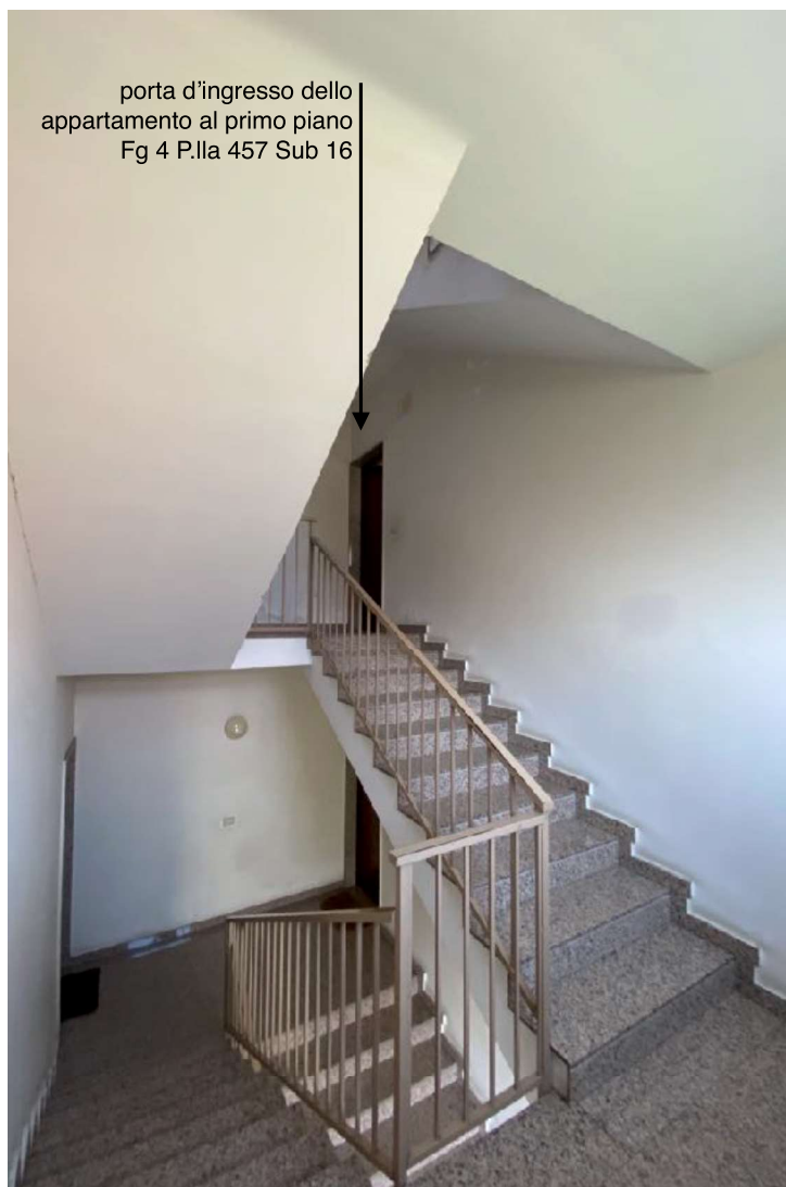
foto 9 - la rampa di scale che conduce al pianerottolo del piano primo. A destra la porta d'ingresso all'appartamento pignorato
