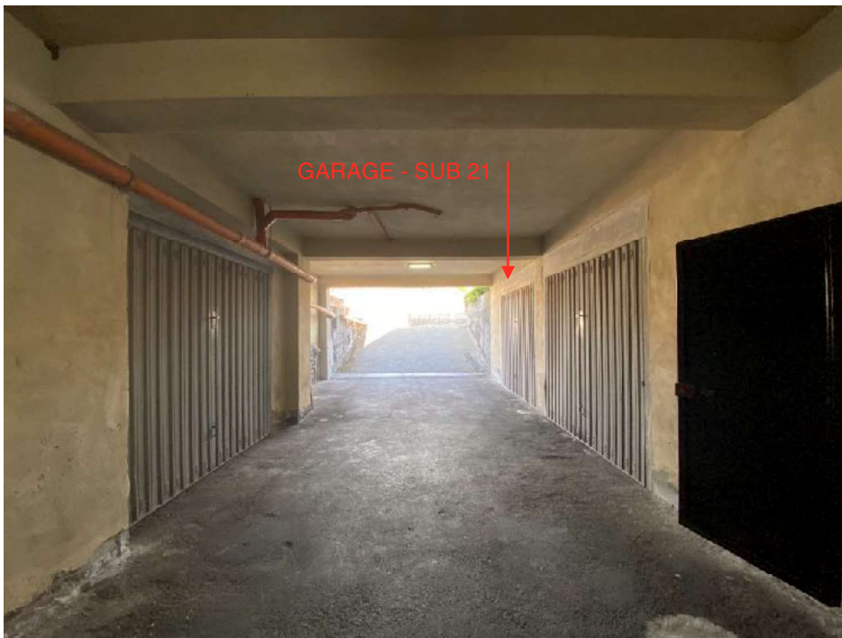
foto 28 e 29 - la corsia di accesso ai garage del piano sottostrada della palazzina B - campo e controcampo
