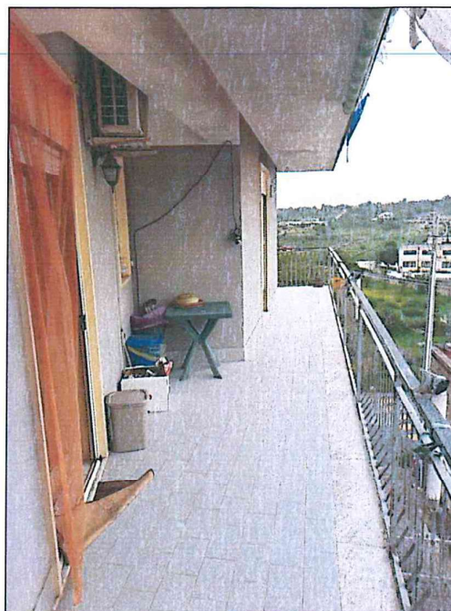
Foto 15-16 - foto dei balconi posti lungo il lato del soggiorno, della cucina e della camera 2. Il balcone è pavimentato, la soletta si trova in buono stato manutentivo in quanto non sono presenti umidità o distacchi di intonaco. Le ringhiere in particolare necessitano di manutenzione ordinaria.
