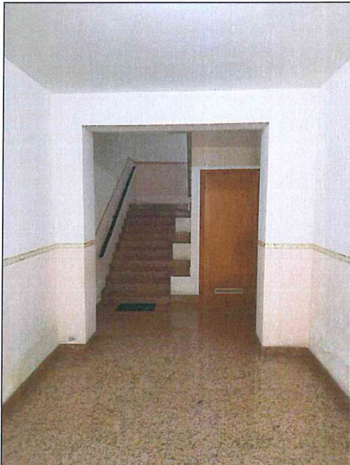
Foto 6-7 - Vista dell'andone di ingresso e del vano scala servente tre piani abitativi: 1°, 2° e 3° piano. La scala comune è in cls armato rivestita in marmo. Non è presente l'ascensore. Al secondo livello - interno 2 - si giunge all'abitazione oggetto di stima.
