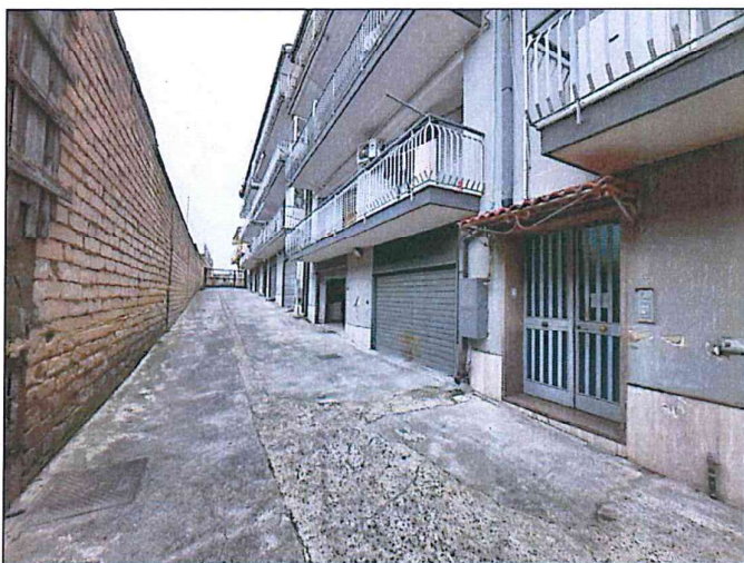
Foto 15-16 - foto dei balconi posti lungo il lato del soggiorno, della cucina e della camera 2. Il balcone è pavimentato, la soletta si trova in buono stato manutentivo in quanto non sono presenti umidità o distacchi di intonaco. Le ringhiere in particolare necessitano di manutenzione ordinaria.
