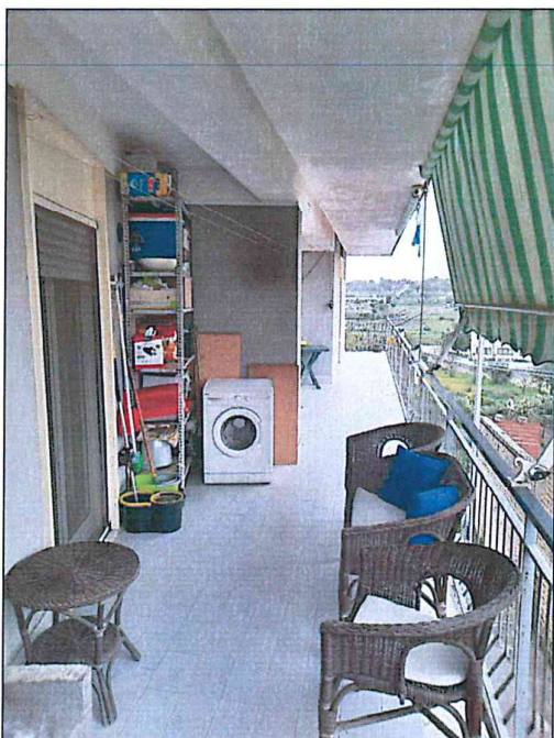
Foto 15-16 - foto dei balconi posti lungo il lato del soggiorno, della cucina e della camera 2. Il balcone è pavimentato, la soletta si trova in buono stato manutentivo in quanto non sono presenti umidità o distacchi di intonaco. Le ringhiere in particolare necessitano di manutenzione ordinaria.
