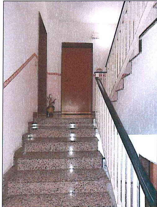
Foto 6-7 - Vista dell'andone di ingresso e del vano scala servente tre piani abitativi: 1°, 2° e 3° piano. La scala comune è in cls armato rivestita in marmo. Non è presente l'ascensore. Al secondo livello - interno 2 - si giunge all'abitazione oggetto di stima.
