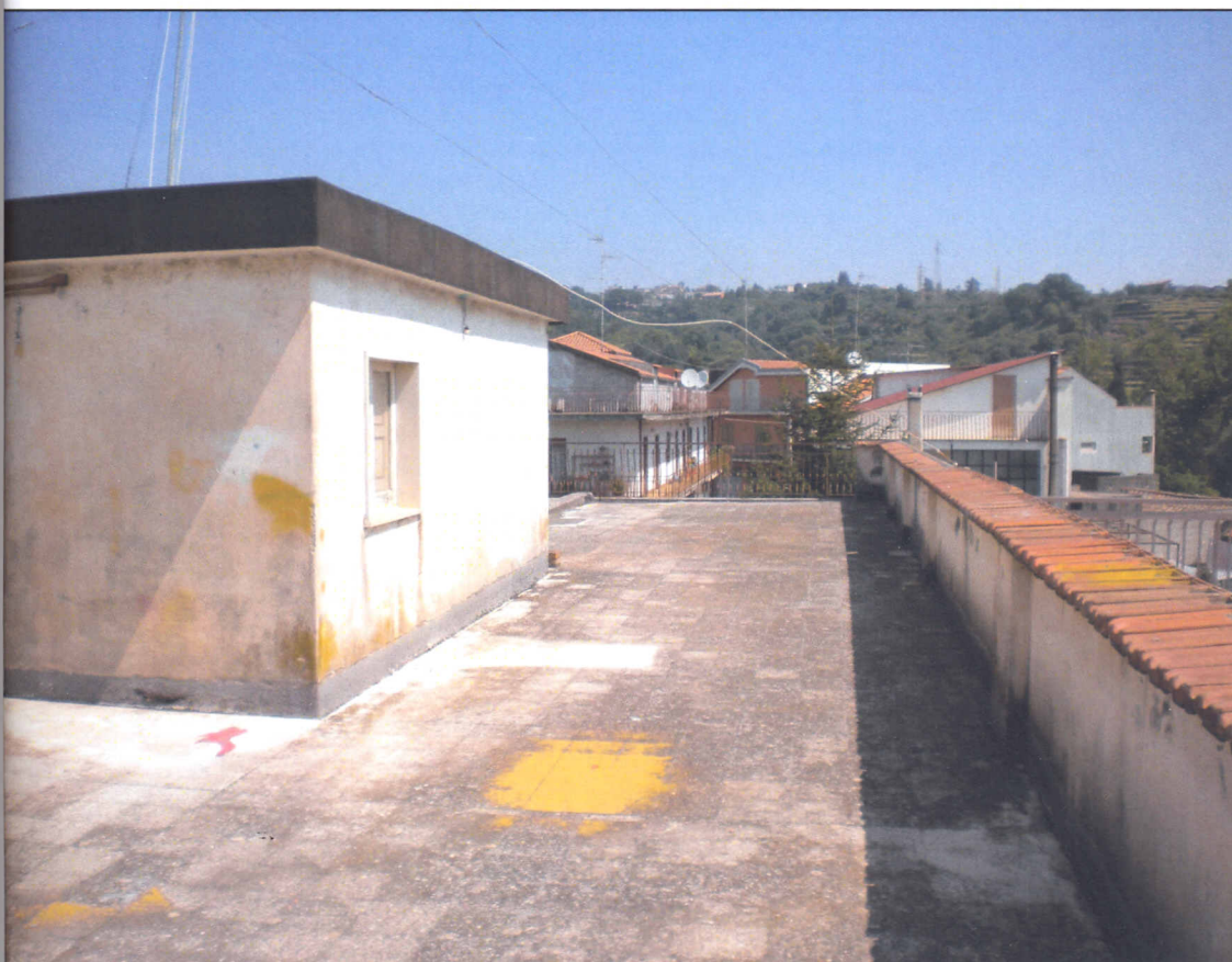
Terrazzo _ Foto n. 13
