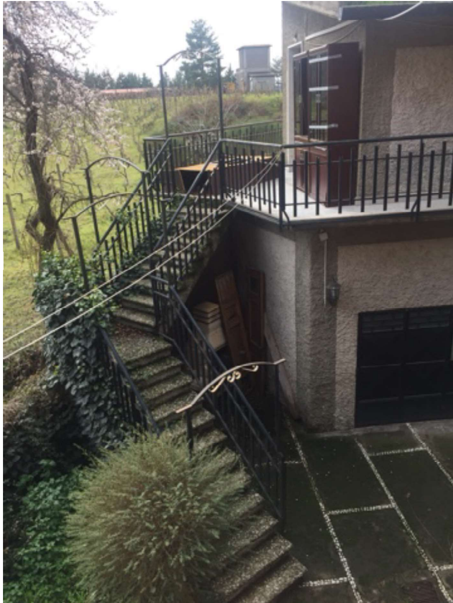
Foto esterna dell'immobile sito a Bronte via Gen. Giovanni Amelio n°8, scala esterna.
