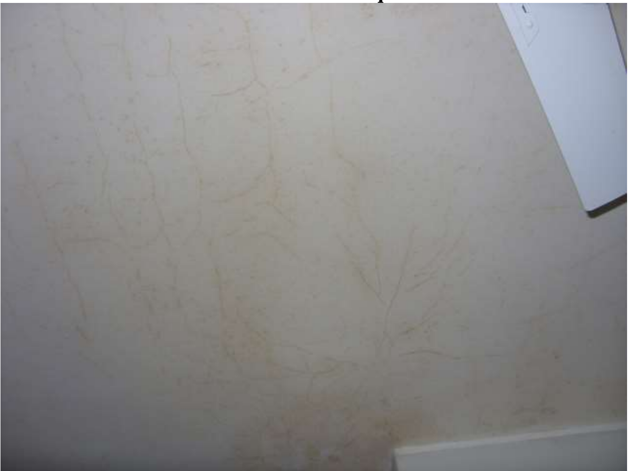
Macchie da infiltrazioni d'acqua discendenti
