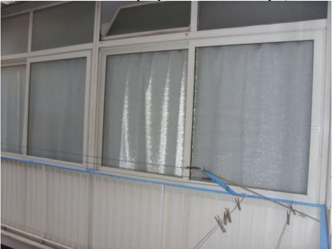
Balcone verandato su prospetto Nord-Ovest da mq 16,40
