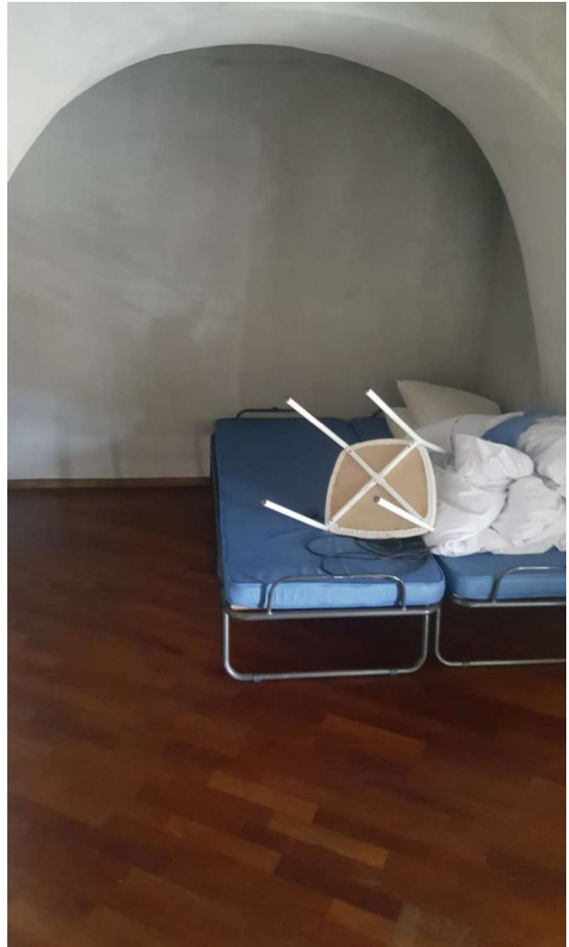
Foto 26: disimpegno piano ammezzato app. 2
