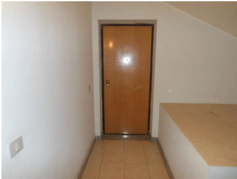
FOTO n. 23 – Locale sottotetto sub. 21 ( porta d'ingresso )
