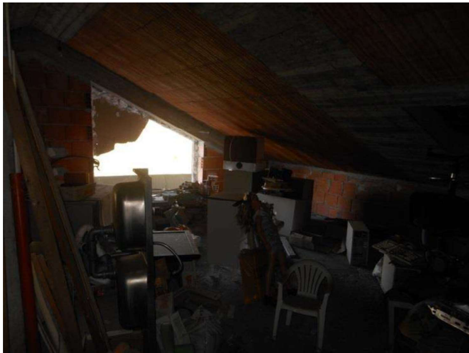
FOTO n. 29 – Locale sottotetto sub. 21 ( vista lato nord/ovest )
