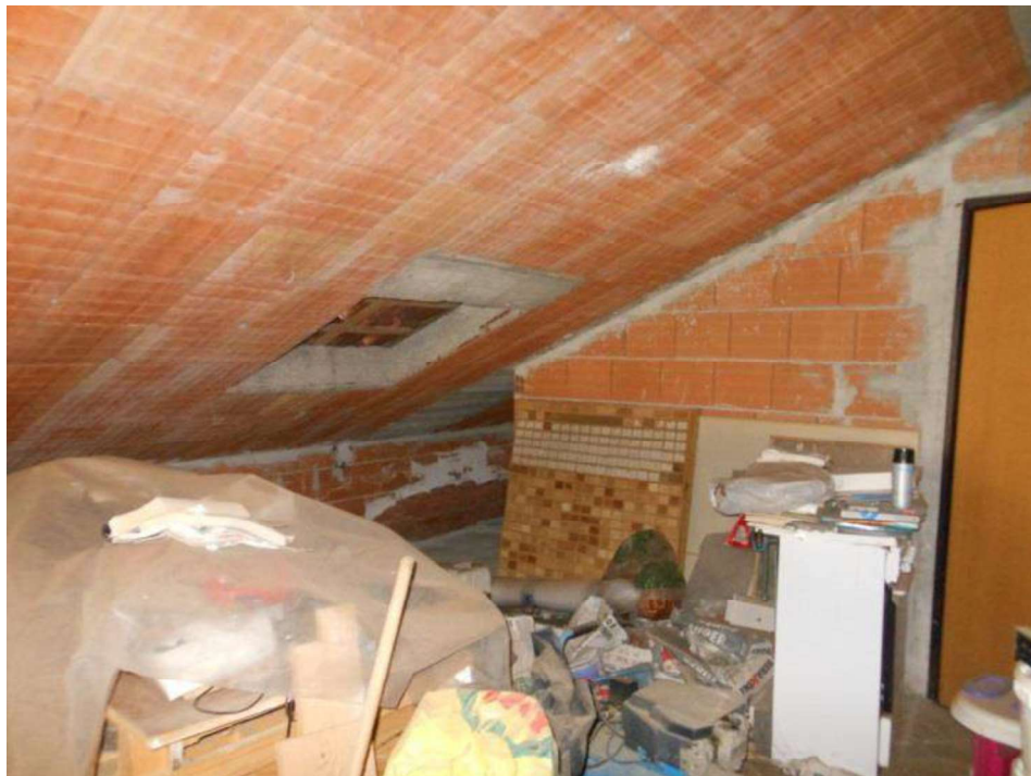
FOTO n. 25 – Locale sottotetto sub. 21 ( vista lato nord/est )
