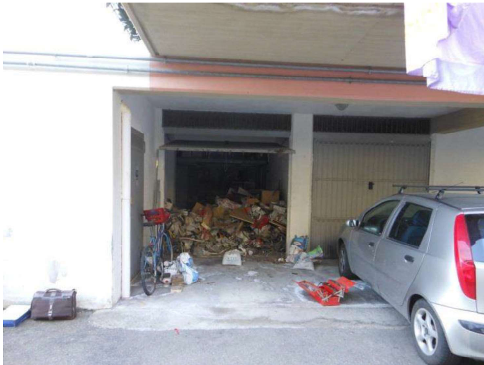
FOTO n. 31 – Garage sub. 33 ( panoramica dell'ingresso )
