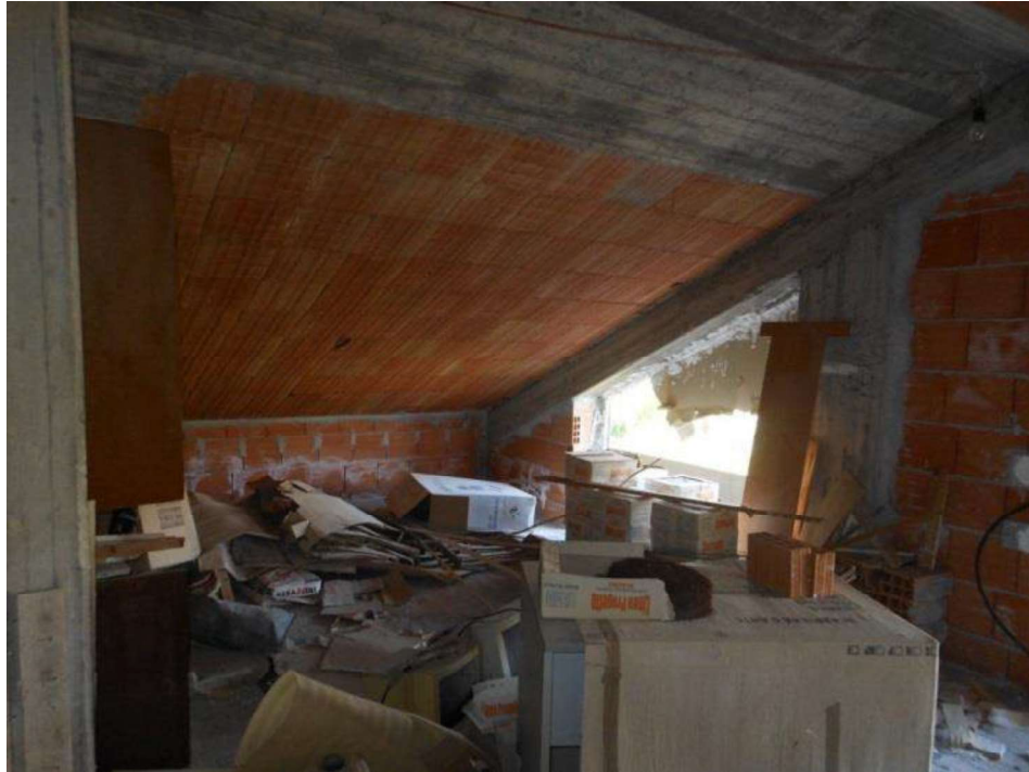
FOTO n. 28 – Locale sottotetto sub. 21 ( vista lato sud/ovest )
