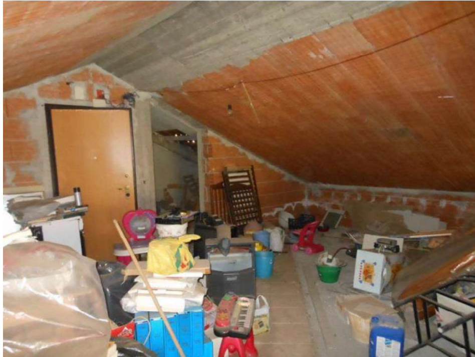
FOTO n. 26 – Locale sottotetto sub. 21 ( vista lato sud/est )
