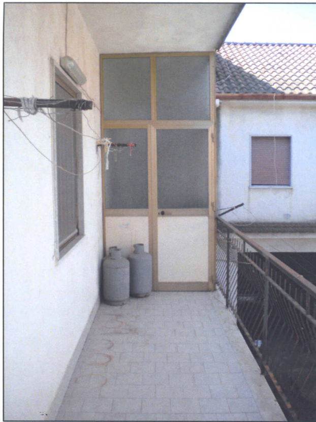
Ballatoio - Lavanderia _ Foto n. 11
