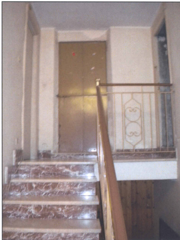
Scala - Ingresso terrazzo _ Foto n. 12
