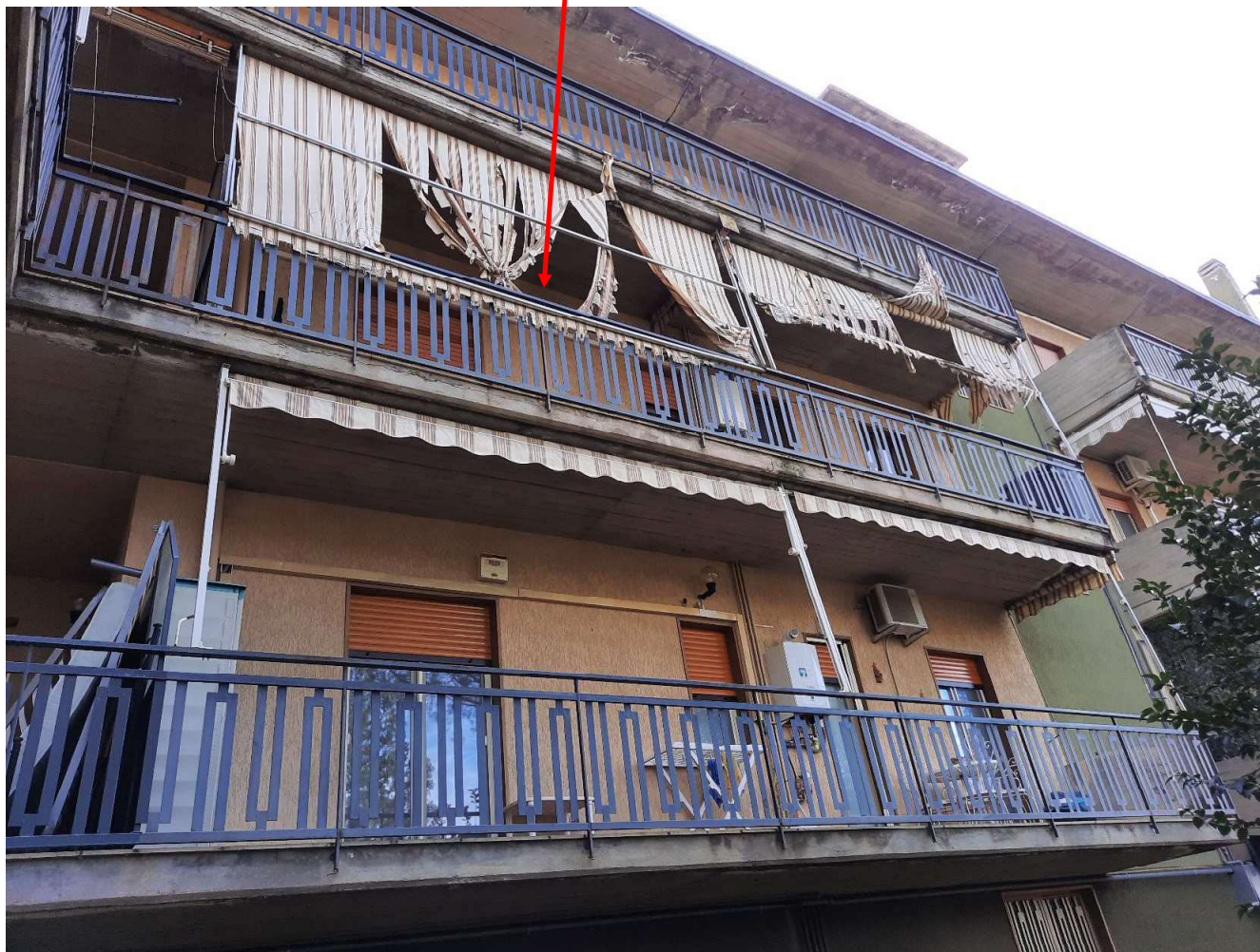
FOTO N. 3 Immobile pignorato sito al Piano Secondo, scala 2 Edificio A
