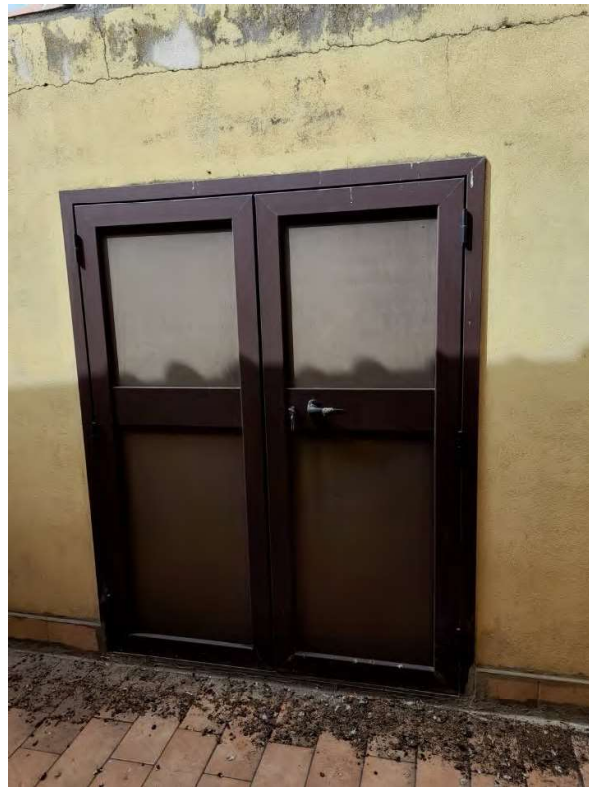
F. 29 - INGRESSO LOCALE SOTTO TETTO
