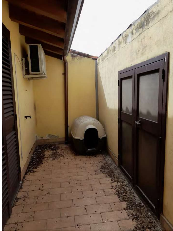
F. 27 - TERRAZZO LATO STRADA
