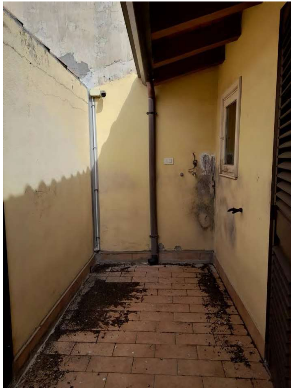
F. 28 - TERRAZZO LATO STRADA
