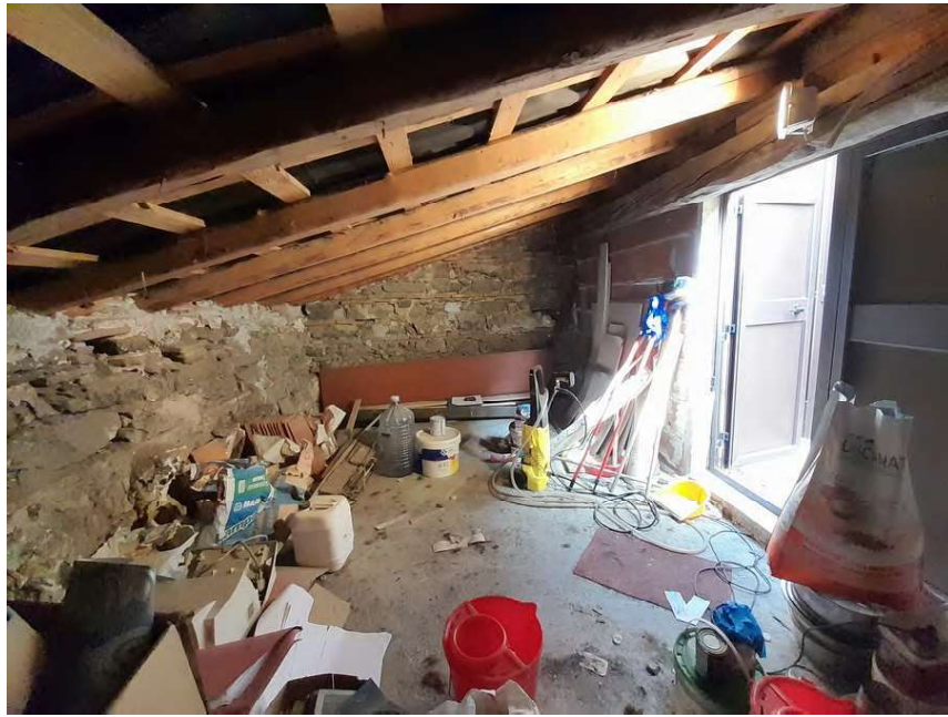
F. 31 - SOTTO TETTO
