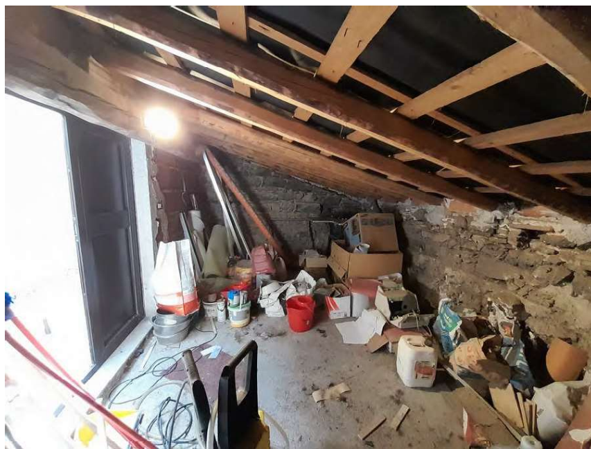
F. 30 - SOTTO TETTO
