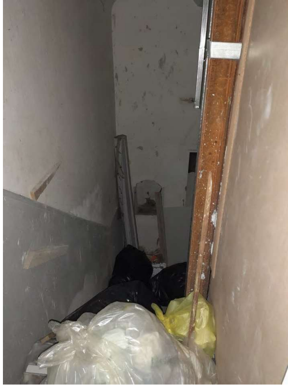
F. 33 - RIPOSTIGLIO SOTTO SCALA
