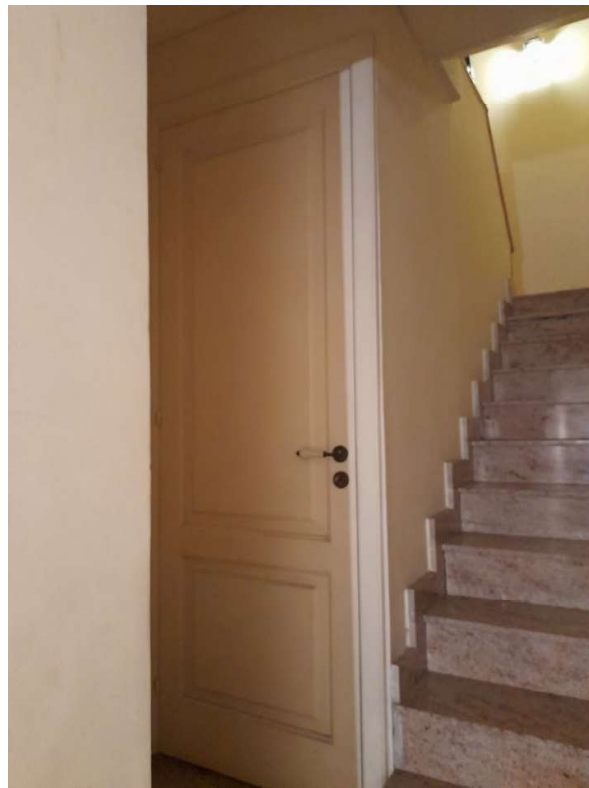
F. 32 - INGRESSO RIPOSTIGLIO SOTTO SCALA
