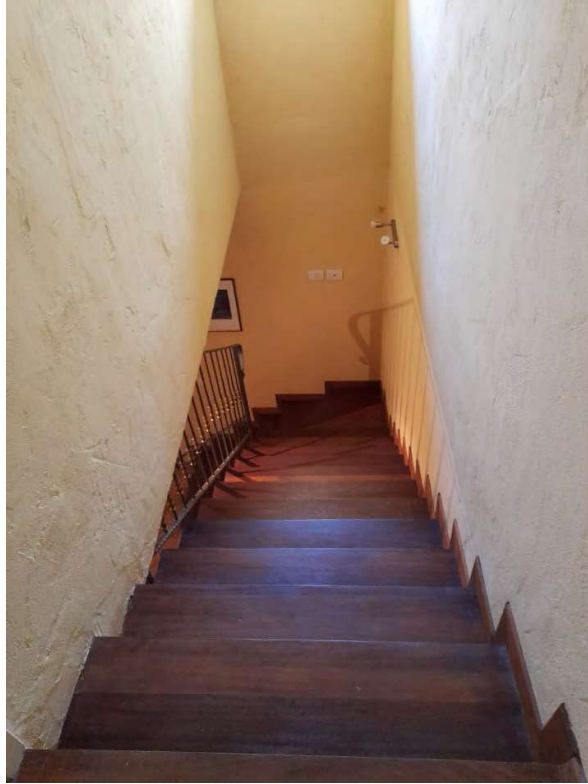
F. 19 - SCALA DI ACCESSO AL PIANO 2
