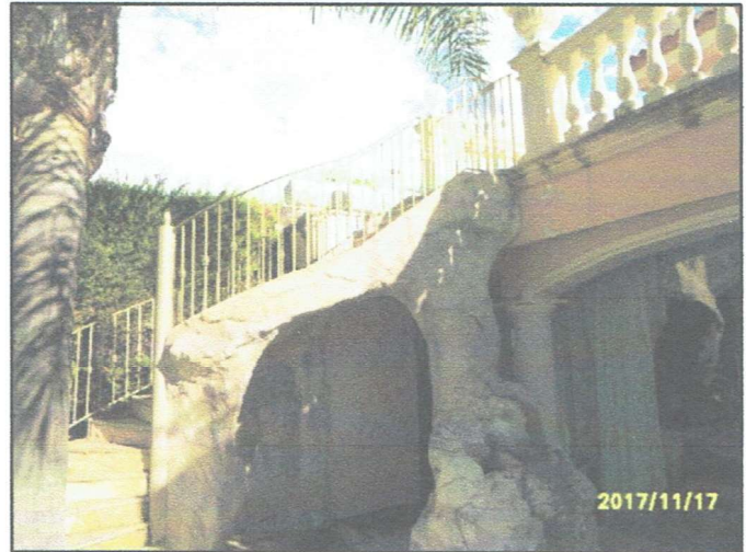
Foto n° 20 - PART. SCALA ESTERNA
