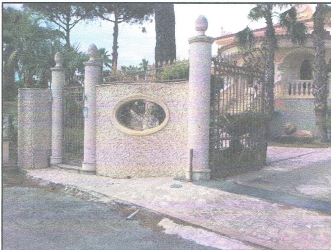
Foto n° 1 - PART. INGRESSO SUD
