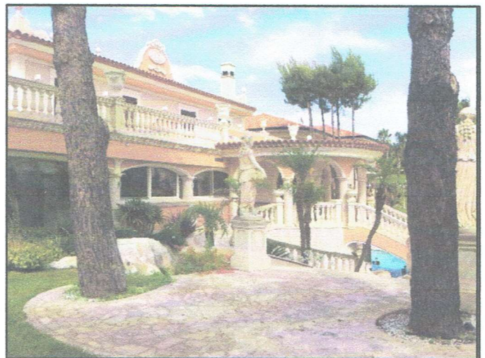
Foto n° 6 - PART. GIARDINO LATO SUD
