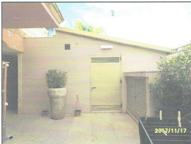
Foto n° 21 - PART. DEPOSITO NORD/OVEST
