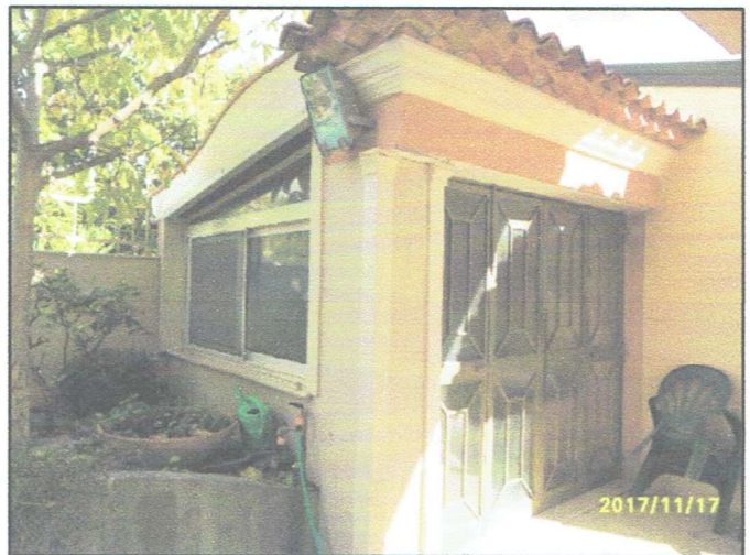
Foto n° 18 - PART. DEPOSITO NORD/EST
