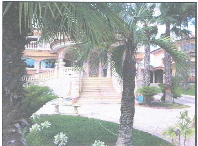
Foto n° 2 - PART. INGRESSO SUD
