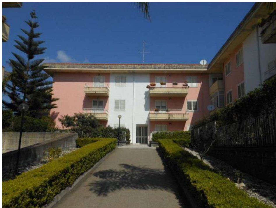
FOTO n. 1 – Prospetto principale palazzina ( lato sud )
