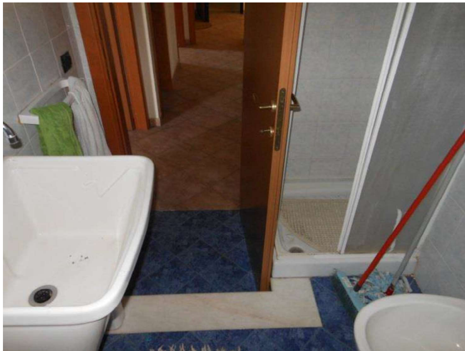
FOTO n. 13 – Appartamento sub. 15 ( lavanderia/wc – vista lato est )
