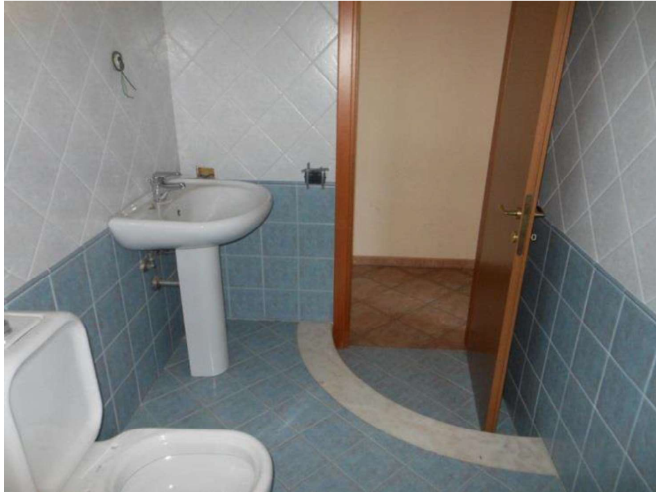
FOTO n. 18 – Appartamento sub. 15 ( bagno – vista lato sud )
