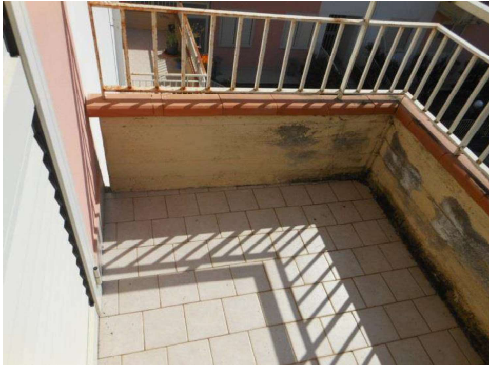
FOTO n. 8 – Appartamento sub. 15 ( balcone lato sud )
