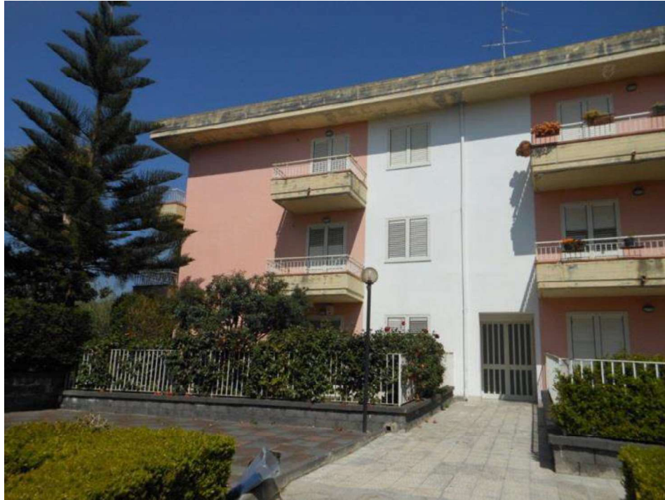
FOTO n. 2 – Prospetto sud ( ingresso scala )
