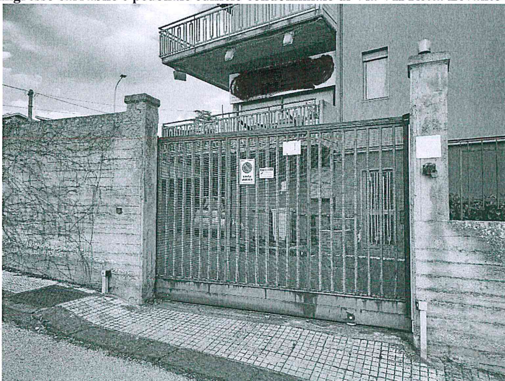
FOTO N. 1-2 Ingresso carrabile e pedonale edificio condominiale di Via VII Retta Levante n. 60 Belpasso
